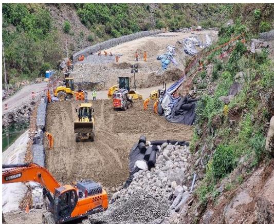
Aplicación de la mezcla de materiales en la base de Terramesh
