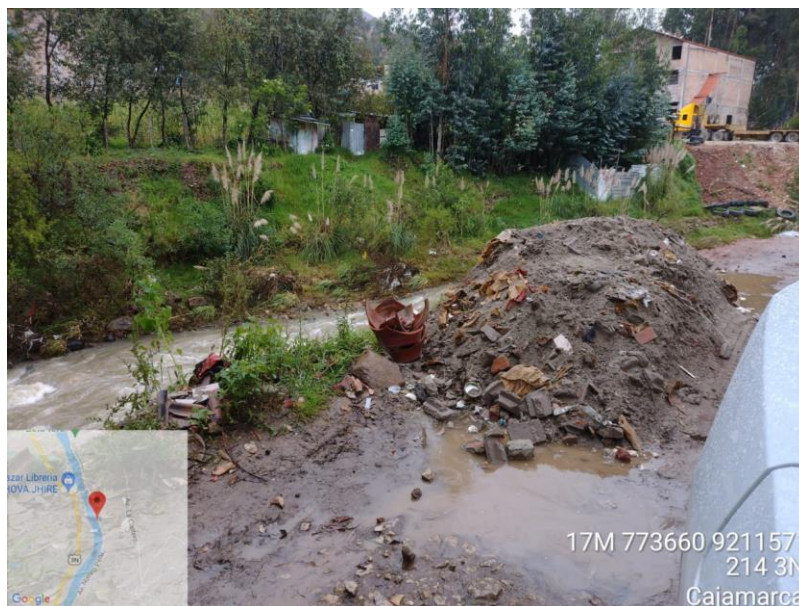
Figura 21 Punto de monitoreo E2- Cajamarca: eliminación de desmontes mes de noviembre 2020
