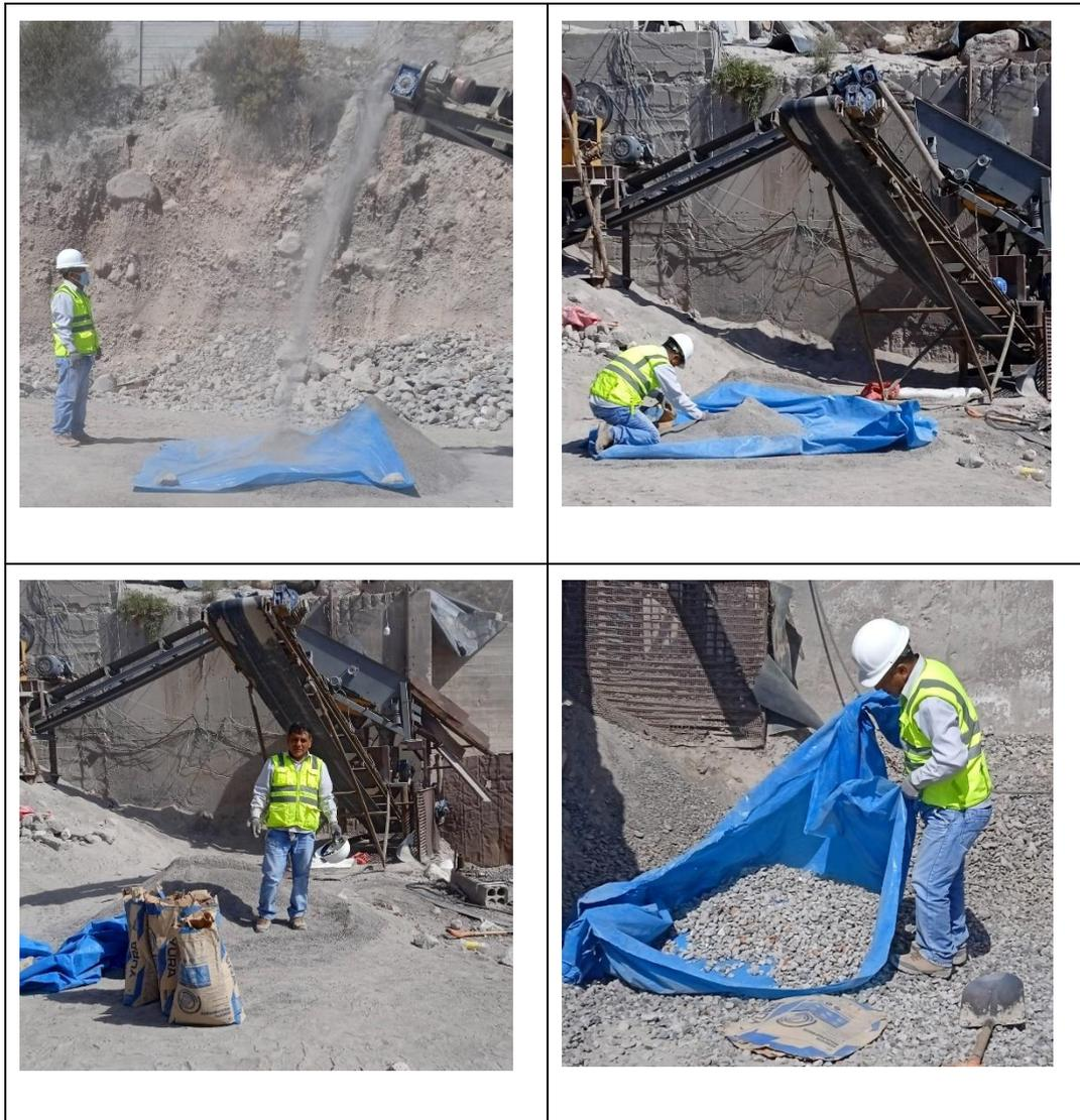
*Figura 6 chancado del material RCD*
