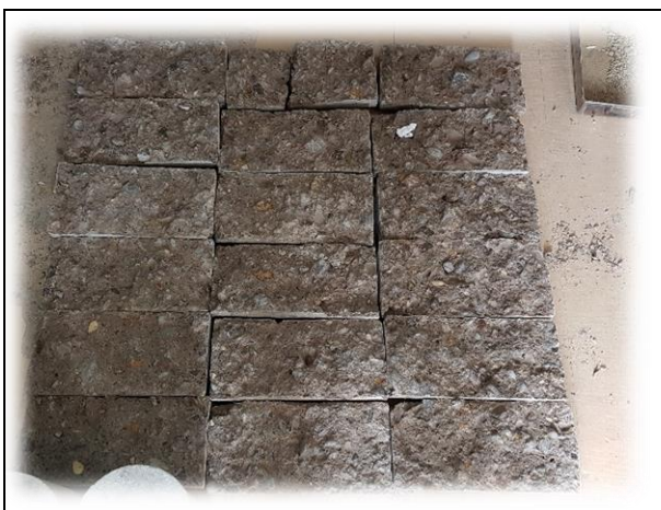
FECHA DE LA FOTOGRAFÍA 08 DE MAR DEL 2022 Evidencia Fotográfica Nº 35 Probetas de concreto rotas en resistencia en tracción
