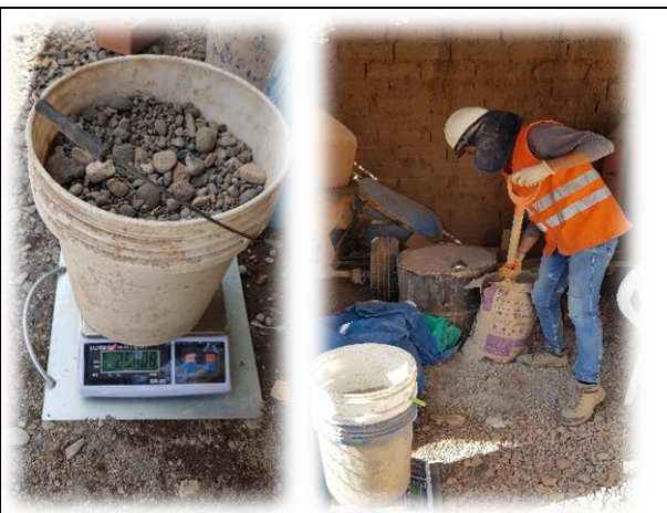
FECHA DE LA FOTOGRAFÍA 08 DE FEBR DEL 2022 Evidencia Fotográfica Nº 17 Pesado de agregado y cemento para mezcla.
