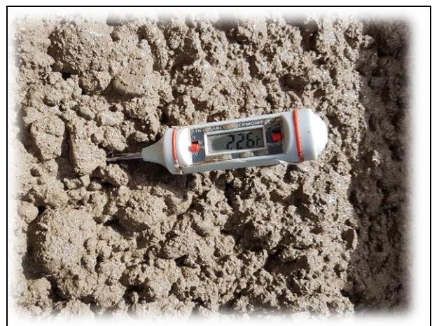
FECHA DE LA FOTOGRAFÍA 08 DE FEBR DEL 2022 Evidencia Fotográfica Nº 22 Temperatura del concreto.
