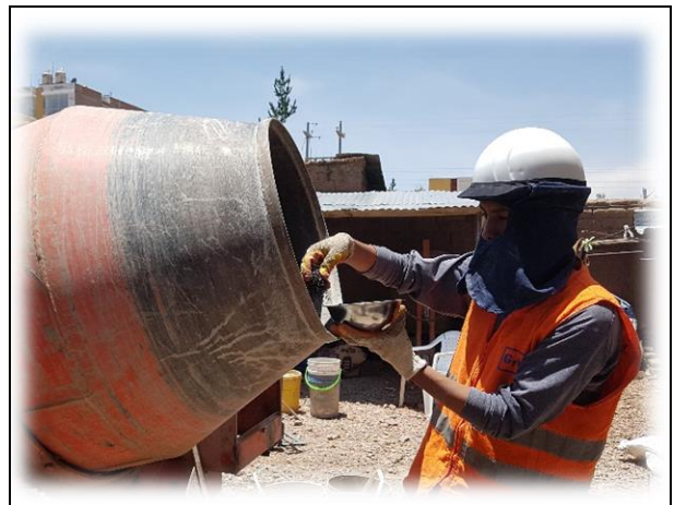
FECHA DE LA FOTOGRAFÍA 08 DE FEBR DEL 2022 Evidencia Fotográfica Nº 20 Adición de la FANR en la mezcla.
