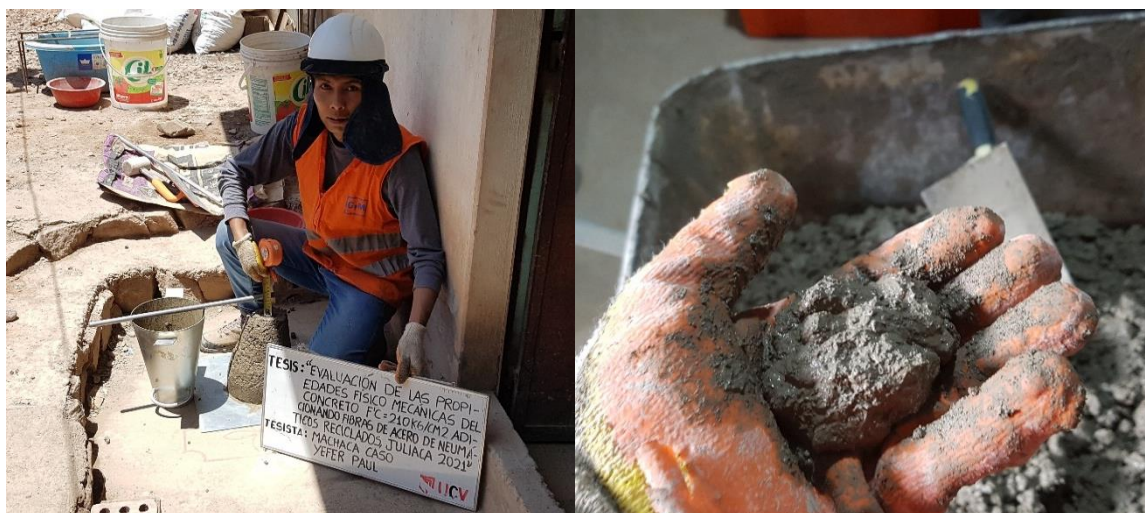
Figura 33. Fotografía de asentamiento y consistencia del concreto
