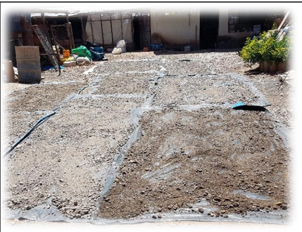
FECHA DE LA FOTOGRAFÍA 07 DE FEBR DEL 2022 Evidencia Fotográfica Nº 15 Secado de agregados.
