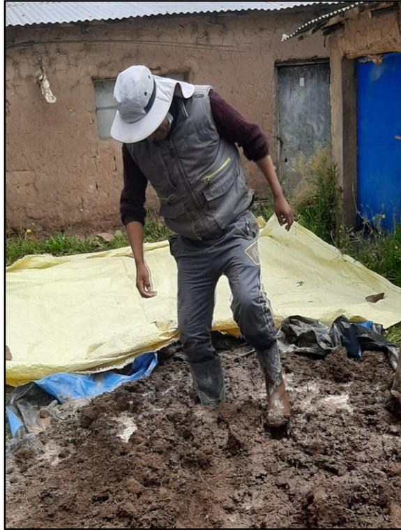
**Fotografía 13:** Preparación de mezcla de barro dormido
