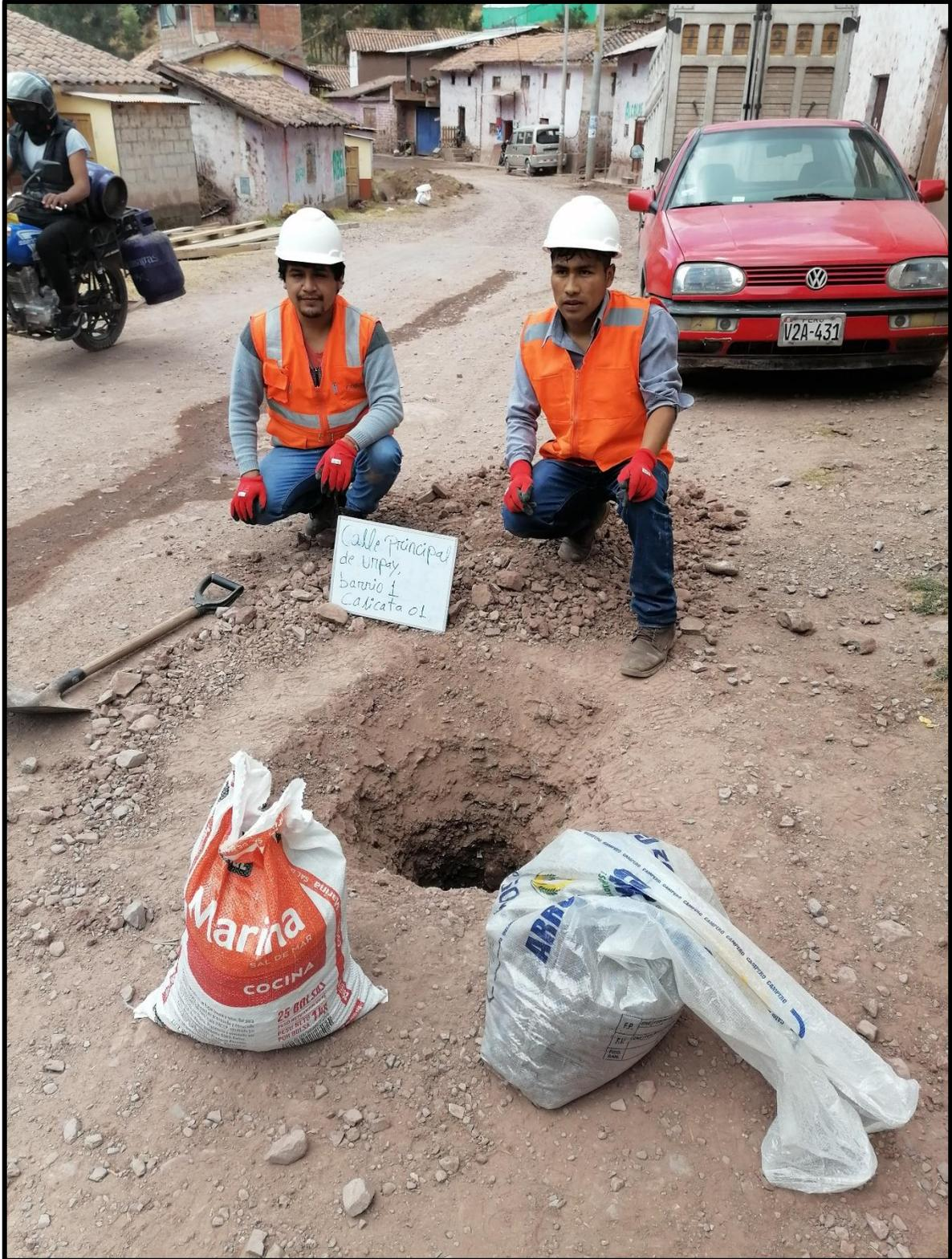
**Foto 03: vista de calicata realizada para la extracción de muestras**
