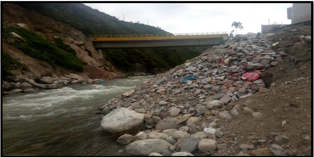
Figura 47 Material de construcción botado a orillas del río Llaucano.
