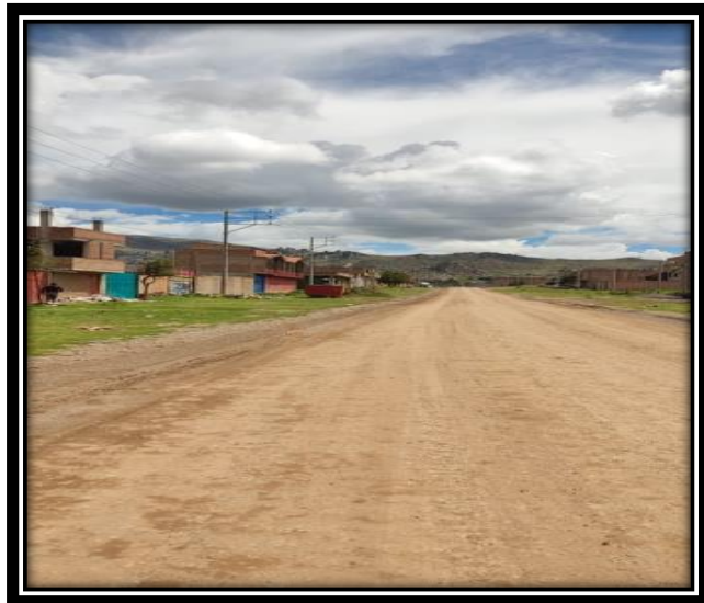
Figura 8 Vista del Km. 0+400 de la avenida industrial
