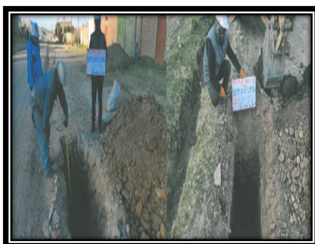
Figura 10 Extracción de material de la carretera de la calicata C-01 Km. 0+400
