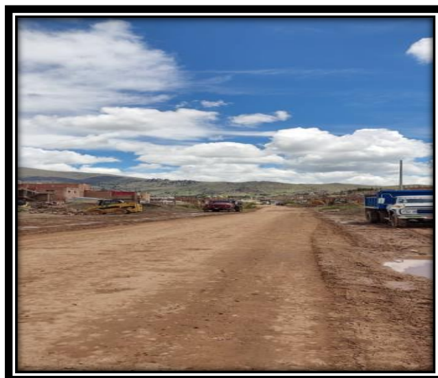
Figura 6 Vista Km 0+00 en la avenida industrial
