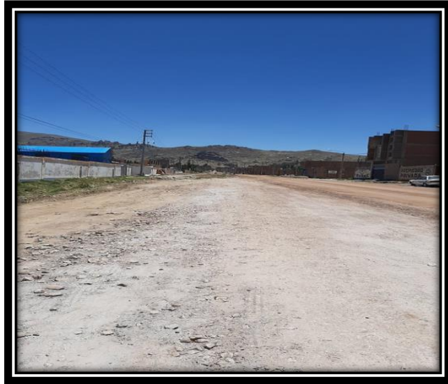
Figura 7 Vista del Km. 1+00 de la avenida industrial.
