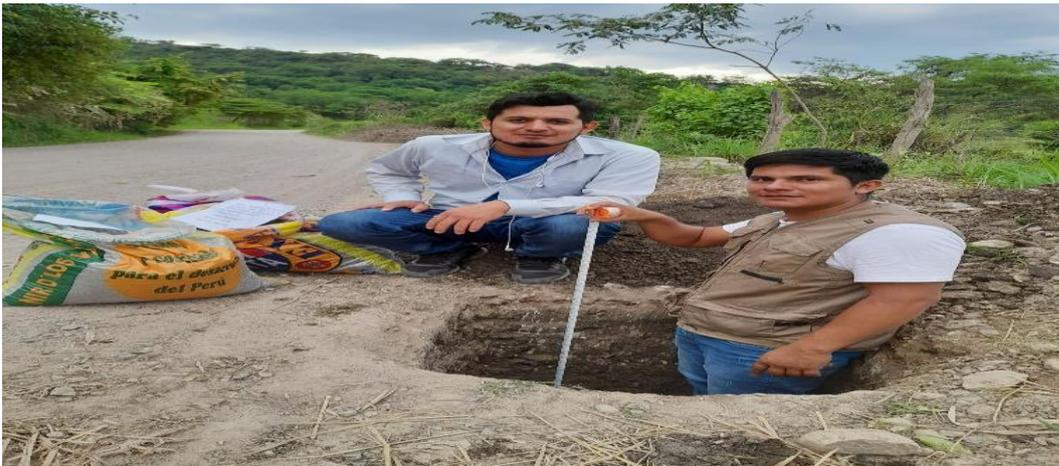
Imagen 4. Excavación de calicata. Fuente: elaboración propia.
