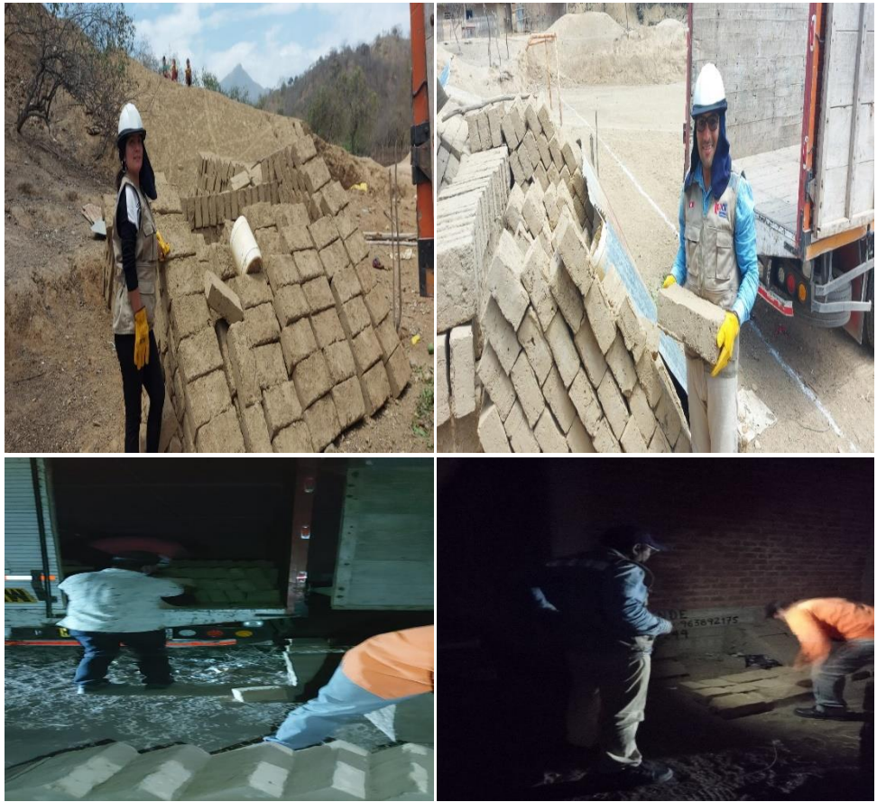
Traslado de adobes desde Kañaris hasta Ferreñafe Fuente: Elaboración propia
