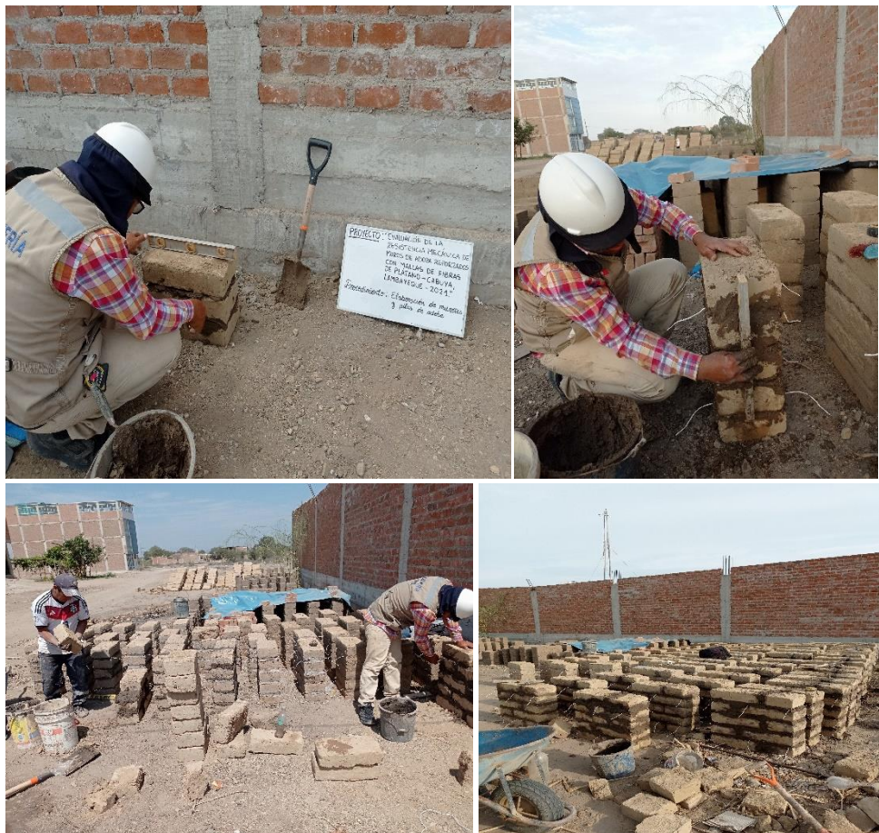
Construcción de muretes y pilas de adobe Fuente: Elaboración propia
