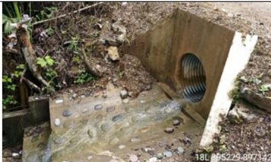
Fotografía 107 y 108: Prog. 04+641, alcantarilla definitiva TMC de 36 pulg. en excelente condición estructural y estado de condición funcional bueno (limpio); con un ancho de vía es de 5.20 m.
