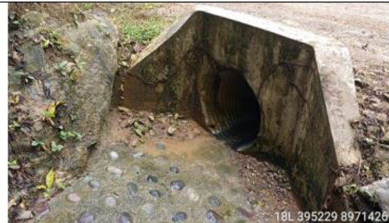
Fotografía 107 y 108: Prog. 04+641, alcantarilla definitiva TMC de 36 pulg. en excelente condición estructural y estado de condición funcional bueno (limpio); con un ancho de vía es de 5.20 m.
