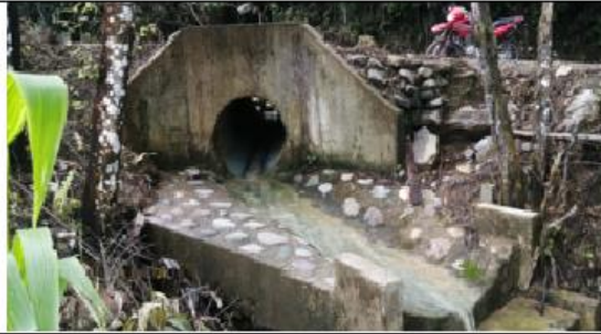
Fotografía 139 y 140: Prog. 06+181, alcantarilla definitiva TMC de 36 pulg. en excelente condición estructural y estado de condición funcional bueno (limpio); con un ancho de vía es de 5.30 m.
