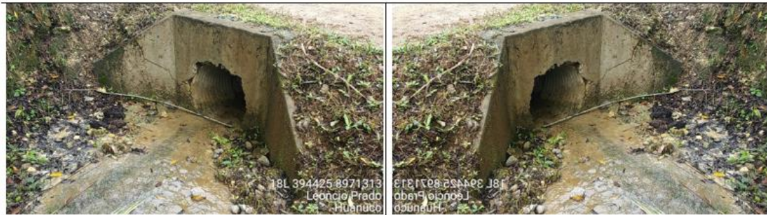
Fotografía 74 y 75: Prog. 03+758, alcantarilla definitiva TMC de 36 pulg. en excelente condición estructural y estado de condición funcional bueno (limpio); con un ancho de vía es de 6.00 m.
