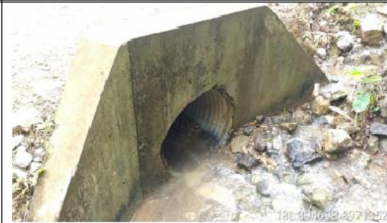
Fotografía 87 y 88: Prog. 04+074, alcantarilla definitiva TMC de 36 pulg. en excelente condición estructural y estado de condición funcional bueno (limpio); con un ancho de vía es de 5.00 m.
