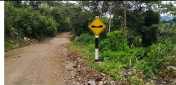
Fotografía 115: Prog. 05+110, señal preventiva en buen estado, ubicado en el lado izquierdo de la vía.
