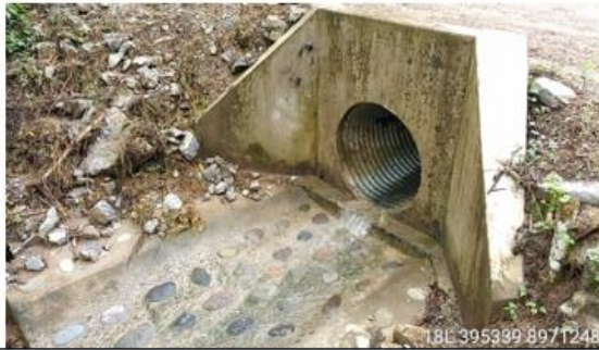
Fotografía 110 y 111: Prog. 04+898, alcantarilla definitiva TMC de 36 pulg. en excelente condición estructural y estado de condición funcional bueno (limpio); con un ancho de vía es de 5.20 m.
