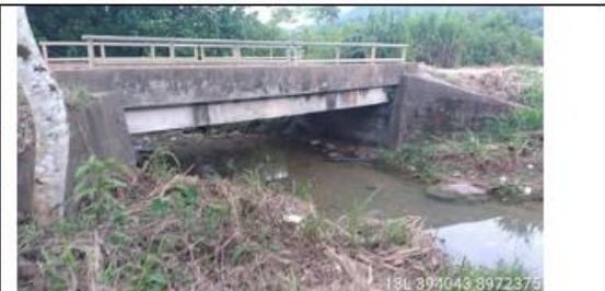
Fotografía 25: Prog. 1+480, puente definitivo de tipo losas con viga, con una condición estructural bueno y condición funcional bueno; fuente de agua con un caudal aproximado de 2.00 m 3 /s.
