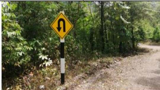
Fotografía 123: Prog. 05+383, señal preventiva en buen estado, ubicado en el lado derecho de la vía.
