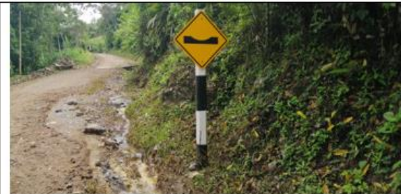
Fotografía 113: Prog. 05+049, señal preventiva en buen estado, ubicado en el lado derecho de la vía.
