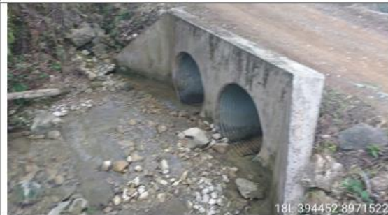
fotografía 61 y 62: Prog. 03+223, Doble alcantarilla definitiva TMC de 48 pulg. en excelente condición estructural y estado de condición funcional bueno (limpio); con un ancho de vía es de 5.10 m.
