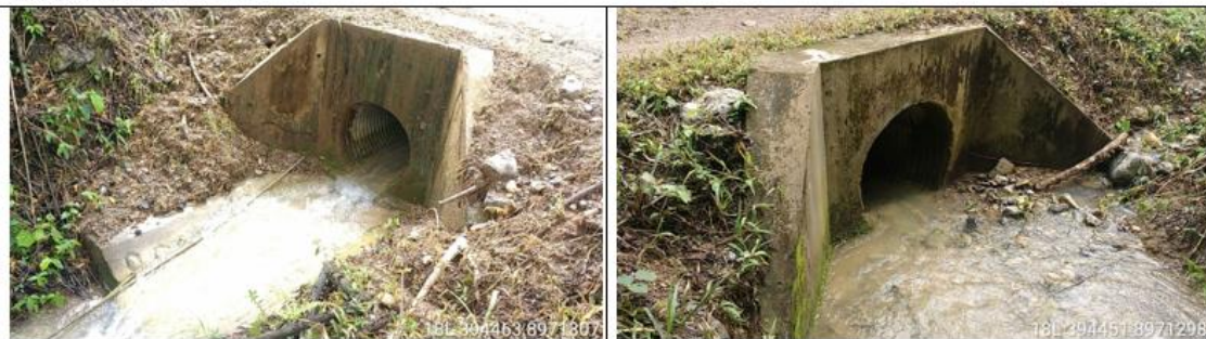
fotografía 76 y 77: Prog. 03+797, alcantarilla definitiva TMC de 36 pulg. en excelente condición estructural y estado de condición funcional bueno (limpio); con un ancho de vía es de 5.80 m.
