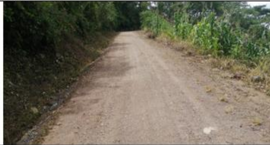
Fotografía 126: Prog. 05+440, superficie de rodadura en buen estado, con un ancho de vía de 4.20 m.
