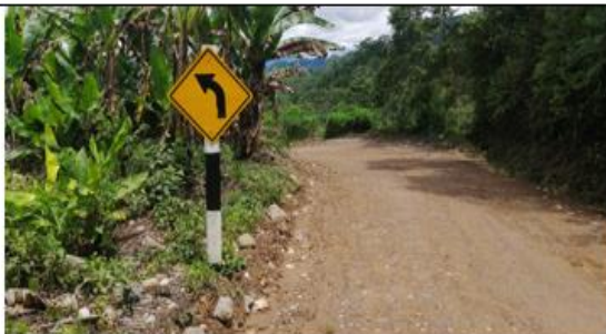
Fotografía 58: Prog. 3+030, señal preventiva en buen estado, ubicado en el lado derecho de la vía.
