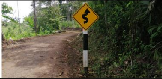
fotografía 82: Prog. 03+922, señal preventiva en buen estado, ubicado en el lado derecho de la vía.
