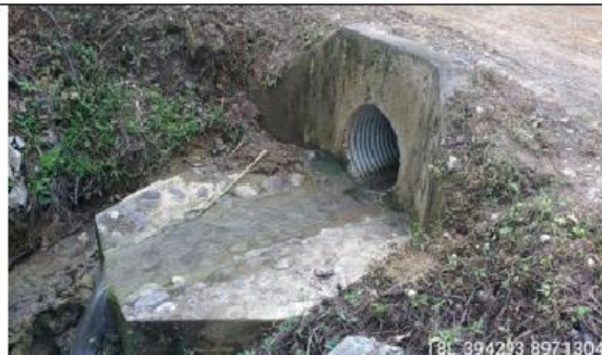
Fotografía 70 y 71: Prog. 03+637, alcantarilla definitiva TMC de 36 pulg. en excelente condición estructural y estado de condición funcional bueno (limpio); con un ancho de vía es de 7.50 m.
