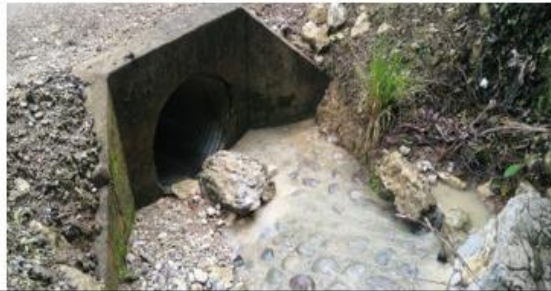
Fotografía 124 y 125: Prog. 05+413, alcantarilla definitiva TMC de 48 pulg. en excelente condición estructural y estado de condición funcional bueno (limpio); con un ancho de vía es de 5.10 m.
