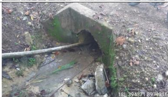
Fotografía 72 y 73: Prog. 03+710, alcantarilla definitiva TMC de 36 pulg. en excelente condición estructural y estado de condición funcional bueno (limpio); con un ancho de vía es de 6.00 m.
