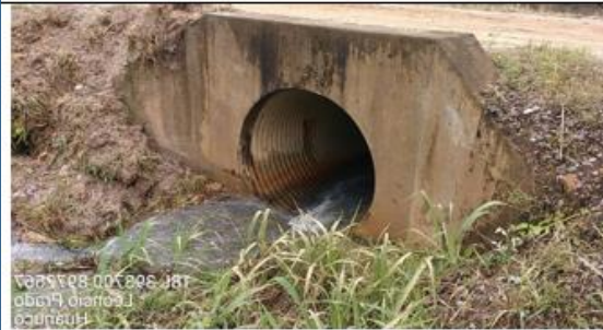
FOTOGRAFIA 22 y 23: Prog. 01+078, alcantarilla definitiva TMC de 48 pulg. En excelente condición estructural y estado de condición funcional bueno (limpio), con un ancho de vía es de 5.00 m.
