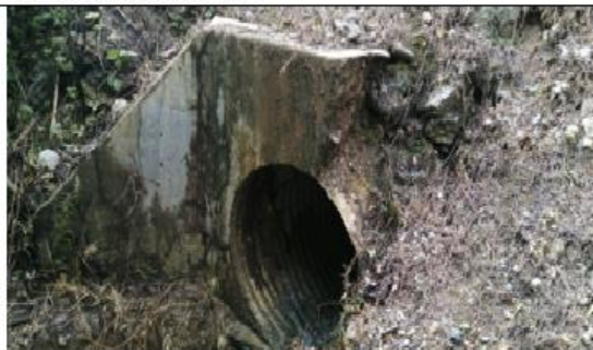
Fotografía 144 y 145: Prog. 06+370, alcantarilla definitiva TMC de 48 pulg. con condición estructural preocupante y estado de condición funcional regular (requiere ser reemplazado por uno nuevo); con un ancho de vía es de 4.00 m.
