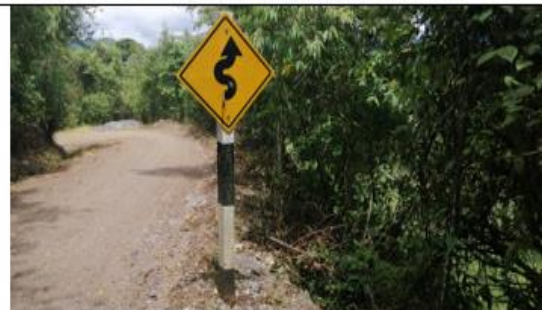
Fotografía 121: Prog. 05+304, señal preventiva en buen estado, ubicado en el lado izquierdo de la vía.
