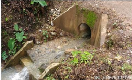
Fotografía 83 y 84: Prog. 03+969, alcantarilla definitiva TMC de 36 pulg. en excelente condición estructural y estado de condición funcional bueno (limpio); con un ancho de vía es de 6.00 m.
