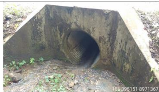
Fotografía 105 y 106: Prog. 04+546, alcantarilla definitiva TMC de 36 pulg. en excelente condición estructural y estado de condición funcional bueno (limpio); con un ancho de vía es de 5.20 m.
