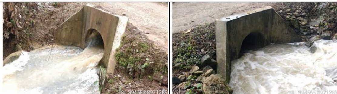
fotografía 80 y 81: Prog. 03+918, alcantarilla definitiva TMC de 48 pulg. en excelente condición estructural y estado de condición funcional bueno (limpio); con un ancho de vía es de 5.30 m.
