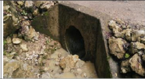
Fotografía 139 y 140: Prog. 06+181, alcantarilla definitiva TMC de 36 pulg. en excelente condición estructural y estado de condición funcional bueno (limpio); con un ancho de vía es de 5.30 m.
