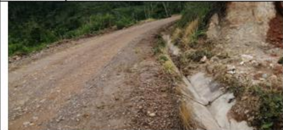
Fotografía 27: Prog. 01+598, inicio de cunetas revestidas de concreto de 0.80 m de ancho y 0.30 m de profundidad, con una longitud de 165.20 m. en excelente condición estructural y estado de condición funcional bueno (limpio), con un ancho de vía es de 5.00 m.
