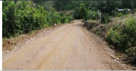
Fotografía 53: Prog. 02+930, superficie de rodadura en buen estado, con un ancho de vía de 4.80 m.
