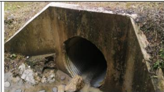
Fotografía 119 y 120: Prog. 05+255, alcantarilla definitiva TMC de 48 pulg. en excelente condición estructural y estado de condición funcional bueno (limpio); con un ancho de vía es de 6.80 m.
