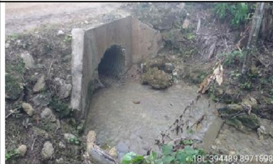
Fotografía 59 y 60: Prog. 03+129, alcantarilla definitiva TMC de 36 pulg. en excelente condición estructural y estado de condición funcional bueno (limpio); con un ancho de vía es de 4.90 m.
