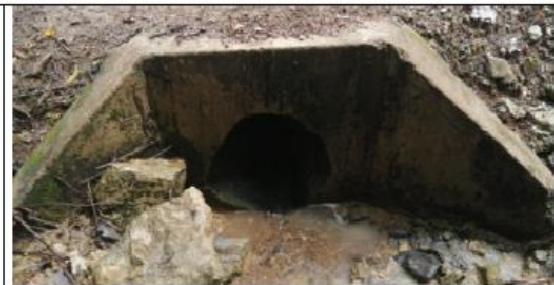
Fotografía 141 y 142: Prog. 06+283, alcantarilla definitiva TMC de 36 pulg. en excelente condición estructural y estado de condición funcional bueno (limpio); con un ancho de vía es de 5.30 m.
