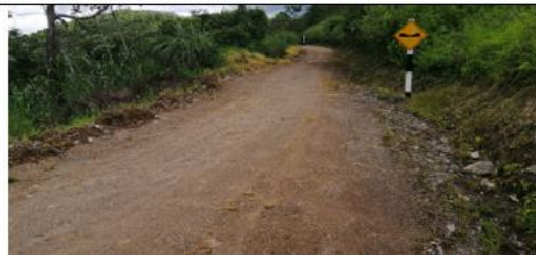
Fotografía 98: Prog. 04+350, superficie de rodadura en buen estado, con un ancho de vía de 4.50 m.
