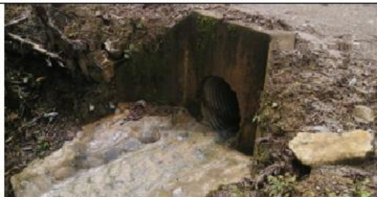
Fotografía 141 y 142: Prog. 06+283, alcantarilla definitiva TMC de 36 pulg. en excelente condición estructural y estado de condición funcional bueno (limpio); con un ancho de vía es de 5.30 m.
