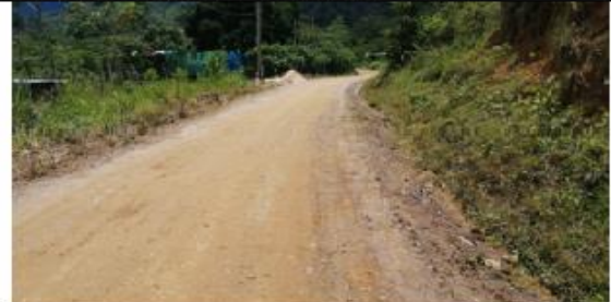
Fotografía 20: Prog. 00+970, superficie de rodadura en buen estado, con un ancho de vía de 4.50 m.
