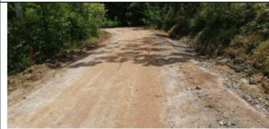
Fotografía 24: Prog. 01+420, superficie de rodadura en buen estado, con un ancho de vía de 4.40 m.
