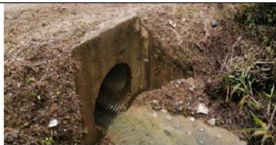
Fotografía 148 y 149: Prog. 06+643, alcantarilla definitiva TMC de 48 pulg. en excelente condición estructural y estado de condición funcional bueno (limpio); con un ancho de vía es de 5.30 m.
