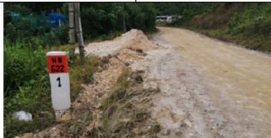
Fotografía 21: Prog. 1+000, poste kilométrico en buen estado, ubicado al lado izquierdo de la vía
