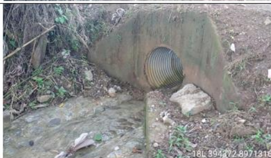
Fotografía 72 y 73: Prog. 03+710, alcantarilla definitiva TMC de 36 pulg. en excelente condición estructural y estado de condición funcional bueno (limpio); con un ancho de vía es de 6.00 m.
