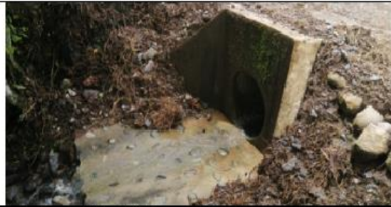
Fotografía 146 y 147: Prog. 06+518, alcantarilla definitiva TMC de 36 pulg. en excelente condición estructural y estado de condición funcional bueno (limpio); con un ancho de vía es de 6.00 m.
