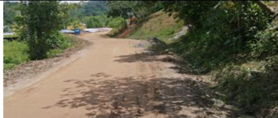
Fotografía 10: Prog. 00+525, superficie de rodadura en buen estado, con un ancho de vía de 4.70 m.
