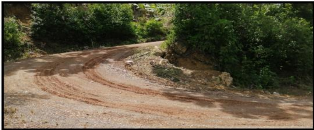
PI 168 (progresiva 02+642.12), radio = 7.06 m.
