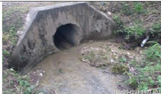
Fotografía 70 y 71: Prog. 03+637, alcantarilla definitiva TMC de 36 pulg. en excelente condición estructural y estado de condición funcional bueno (limpio); con un ancho de vía es de 7.50 m.
