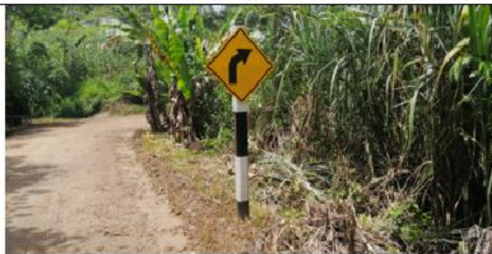
Fotografía 69: Prog. 03+615, señal preventiva en buen estado, ubicado en el lado izquierdo de la vía.
