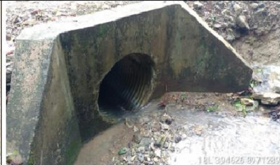
Fotografía 83 y 84: Prog. 03+969, alcantarilla definitiva TMC de 36 pulg. en excelente condición estructural y estado de condición funcional bueno (limpio); con un ancho de vía es de 6.00 m.
