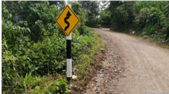
Fotografía 118: Prog. 05+197, señal preventiva en buen estado, ubicado en el lado izquierdo de la vía.
