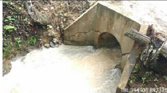
Fotografía 96 y 97: Prog. 04+305, alcantarilla definitiva TMC de 48 pulg. en excelente condición estructural y estado de condición funcional bueno (limpio); con un ancho de vía es de 5.10 m.
