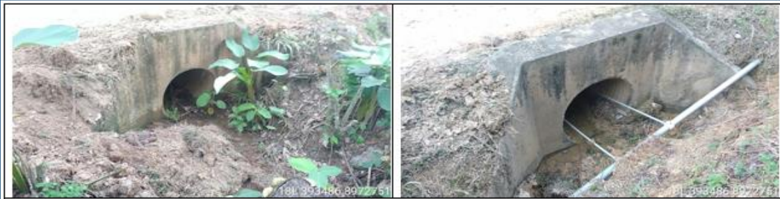
Fotografía 15 Y 16: Prog. 00+781, alcantarilla definitiva TMC de 36 pulg. en excelente condición estructural y en regular estado de condición funcional (parcialmente obstruida), por lo que es necesario hacer el mantenimiento; con un ancho de vía es de 5.10 m. observando una instalación de tubería dentro de la alcantarilla, se recomienda realizar una inspección juntamente con las autoridades y tomar las medidas adecuadas.
