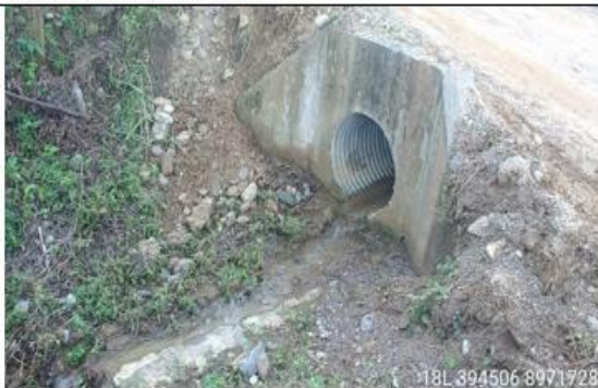
Fotografía 56 y 57: Prog. 02+991, alcantarilla definitiva TMC de 36 pulg. En excelente condición estructural y estado de condición funcional bueno (limpio); con un ancho de vía es de 4.70 m.
