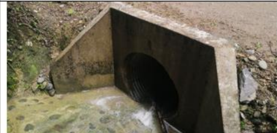
Fotografía 116 y 117: Prog. 05+170, alcantarilla definitiva TMC de 48 pulg. en excelente condición estructural y estado de condición funcional bueno (limpio); con un ancho de vía es de 5.20 m.
