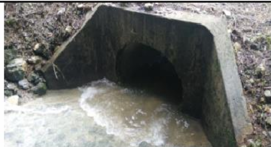
Fotografía 127 y 128: Prog. 05+502, alcantarilla definitiva TMC de 48 pulg. en excelente condición estructural y estado de condición funcional bueno (limpio); con un ancho de vía es de 5.10 m.
