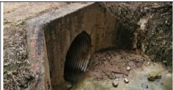
Fotografía 148 y 149: Prog. 06+643, alcantarilla definitiva TMC de 48 pulg. en excelente condición estructural y estado de condición funcional bueno (limpio); con un ancho de vía es de 5.30 m.
