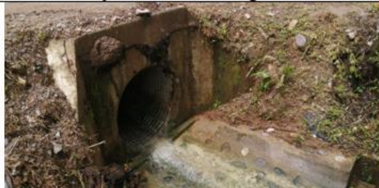
Fotografía 116 y 117: Prog. 05+170, alcantarilla definitiva TMC de 48 pulg. en excelente condición estructural y estado de condición funcional bueno (limpio); con un ancho de vía es de 5.20 m.
