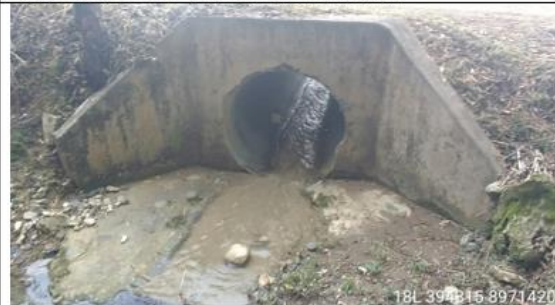
fotografía 63 y 64: Prog. 03+400, alcantarilla definitiva TMC de 48 pulg. en excelente condición estructural y estado de condición funcional bueno (limpio); con un ancho de vía es de 5.00 m.
