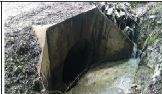
Fotografía 144 y 145: Prog. 06+370, alcantarilla definitiva TMC de 48 pulg. con condición estructural preocupante y estado de condición funcional regular (requiere ser reemplazado por uno nuevo); con un ancho de vía es de 4.00 m.
