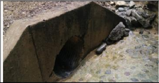
Fotografía 146 y 147: Prog. 06+518, alcantarilla definitiva TMC de 36 pulg. en excelente condición estructural y estado de condición funcional bueno (limpio); con un ancho de vía es de 6.00 m.
