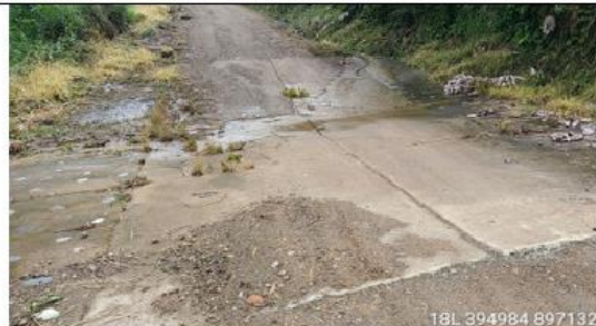
Fotografía 100: Prog. 04+388, badén de concreto en excelente condición estructural y estado de condición funcional regular (parcialmente obstruido), requiere de limpieza y con un ancho de 4.50 m y 12.00 m de largo.
