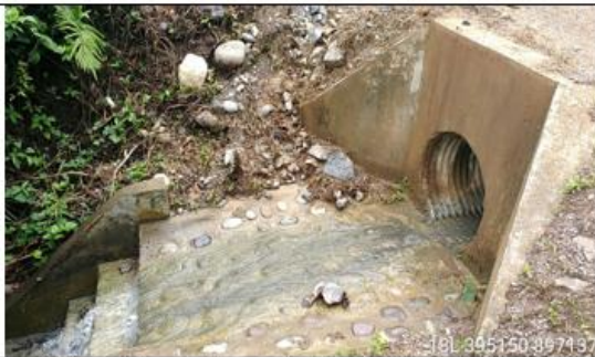
Fotografía 105 y 106: Prog. 04+546, alcantarilla definitiva TMC de 36 pulg. en excelente condición estructural y estado de condición funcional bueno (limpio); con un ancho de vía es de 5.20 m.
