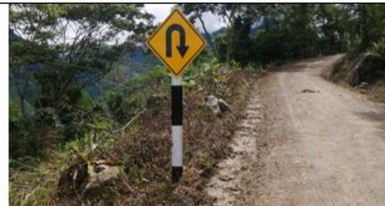
Fotografía 152: Prog. 06+713, señal preventiva en buen estado, ubicado en el lado izquierdo de la vía.
