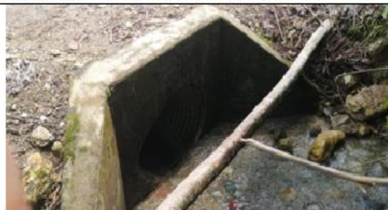
Fotografía 129 y 130: Prog. 05+624, alcantarilla definitiva TMC de 36 pulg. en excelente condición estructural y estado de condición funcional bueno (limpio); con un ancho de vía es de 5.20 m.
