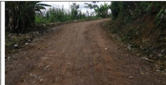
Fotografía 86: Prog. 03+990, superficie de rodadura en buen estado, con un ancho de vía de 4.40 m.
