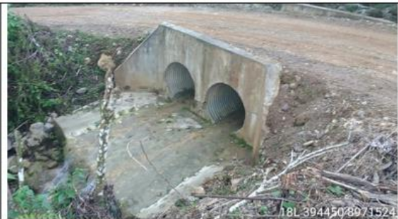
fotografía 61 y 62: Prog. 03+223, Doble alcantarilla definitiva TMC de 48 pulg. en excelente condición estructural y estado de condición funcional bueno (limpio); con un ancho de vía es de 5.10 m.
