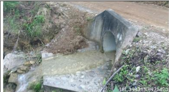
fotografía 63 y 64: Prog. 03+400, alcantarilla definitiva TMC de 48 pulg. en excelente condición estructural y estado de condición funcional bueno (limpio); con un ancho de vía es de 5.00 m.
