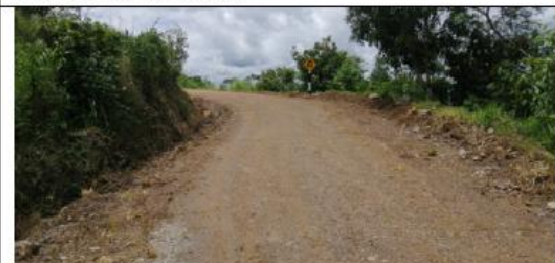
Fotografía 65: Prog. 03+435, superficie de rodadura en buen estado, con un ancho de vía de 4.30 m.
