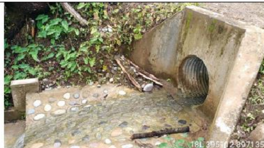
Fotografía 102 y 103: Prog. 04+502, alcantarilla definitiva TMC de 36 pulg. en excelente condición estructural y estado de condición funcional bueno (limpio); con un ancho de vía es de 6.00 m.
