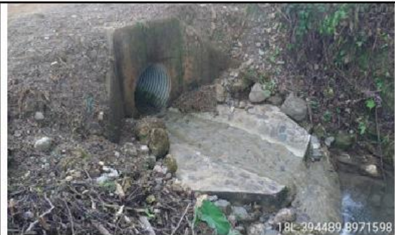
Fotografía 59 y 60: Prog. 03+129, alcantarilla definitiva TMC de 36 pulg. en excelente condición estructural y estado de condición funcional bueno (limpio); con un ancho de vía es de 4.90 m.
