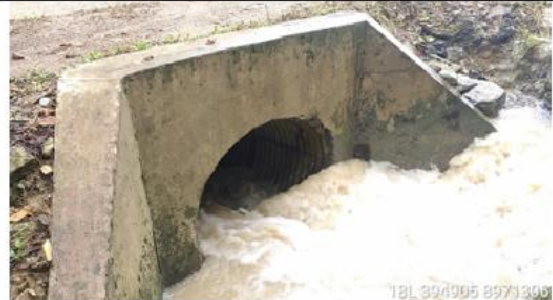
Fotografía 96 y 97: Prog. 04+305, alcantarilla definitiva TMC de 48 pulg. en excelente condición estructural y estado de condición funcional bueno (limpio); con un ancho de vía es de 5.10 m.
