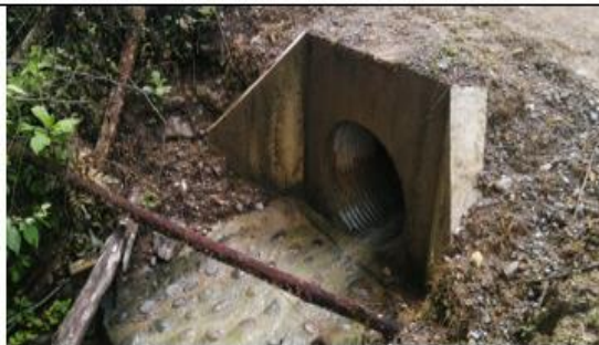
Fotografía 119 y 120: Prog. 05+255, alcantarilla definitiva TMC de 48 pulg. en excelente condición estructural y estado de condición funcional bueno (limpio); con un ancho de vía es de 6.80 m.
