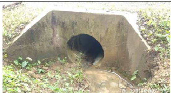
Fotografía 102 y 103: Prog. 04+502, alcantarilla definitiva TMC de 36 pulg. en excelente condición estructural y estado de condición funcional bueno (limpio); con un ancho de vía es de 6.00 m.
