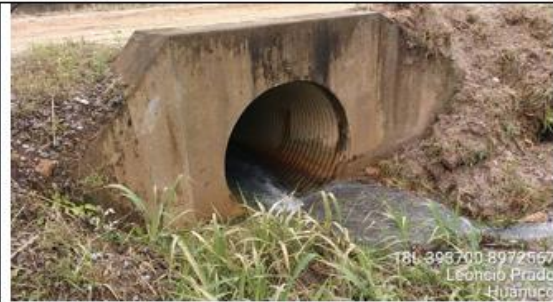
FOTOGRAFIA 22 y 23: Prog. 01+078, alcantarilla definitiva TMC de 48 pulg. En excelente condición estructural y estado de condición funcional bueno (limpio), con un ancho de vía es de 5.00 m.
