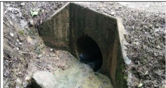
Fotografía 150 y 151: Prog. 06+670, alcantarilla definitiva TMC de 36 pulg. en excelente condición estructural y estado de condición funcional bueno (limpio); con un ancho de vía es de 5.10 m.
