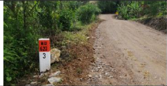
Fotografía 54: Prog. 02+950, poste kilométrico en buen estado, ubicado al lado izquierdo de la vía.
