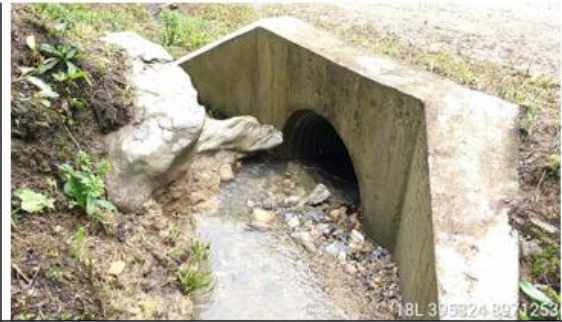
Fotografía 110 y 111: Prog. 04+898, alcantarilla definitiva TMC de 36 pulg. en excelente condición estructural y estado de condición funcional bueno (limpio); con un ancho de vía es de 5.20 m.
