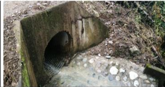
Fotografía 124 y 125: Prog. 05+413, alcantarilla definitiva TMC de 48 pulg. en excelente condición estructural y estado de condición funcional bueno (limpio); con un ancho de vía es de 5.10 m.
