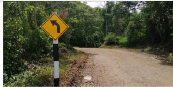
Fotografía 68: Prog. 03+600, señal preventiva en buen estado, ubicado en el lado izquierdo de la vía.
