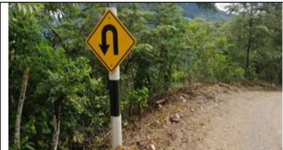
Fotografía 153: Prog. 06+804, señal preventiva en buen estado, ubicado en el lado derecho de la vía.
