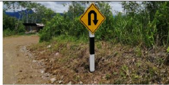
Fotografía 67: Prog. 03+522, señal preventiva en buen estado, ubicado en el lado izquierdo de la vía.
