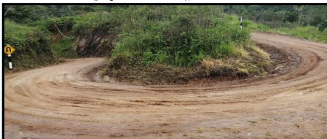
PI 43 (progresiva 01+931.52), radio = 7.50 m.
