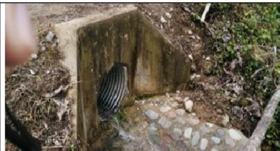
Fotografía 129 y 130: Prog. 05+624, alcantarilla definitiva TMC de 36 pulg. en excelente condición estructural y estado de condición funcional bueno (limpio); con un ancho de vía es de 5.20 m.
