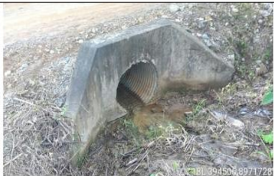
Fotografía 56 y 57: Prog. 02+991, alcantarilla definitiva TMC de 36 pulg. En excelente condición estructural y estado de condición funcional bueno (limpio); con un ancho de vía es de 4.70 m.
