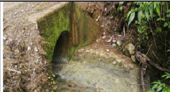
Fotografía 127 y 128: Prog. 05+502, alcantarilla definitiva TMC de 48 pulg. en excelente condición estructural y estado de condición funcional bueno (limpio); con un ancho de vía es de 5.10 m.
