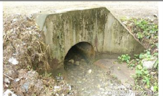
Fotografía 87 y 88: Prog. 04+074, alcantarilla definitiva TMC de 36 pulg. en excelente condición estructural y estado de condición funcional bueno (limpio); con un ancho de vía es de 5.00 m.
