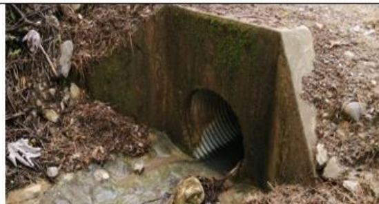
Fotografía 150 y 151: Prog. 06+670, alcantarilla definitiva TMC de 36 pulg. en excelente condición estructural y estado de condición funcional bueno (limpio); con un ancho de vía es de 5.10 m.
