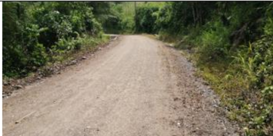
Fotografía 109: Prog. 04+860, superficie de rodadura en buen estado, con un ancho de vía de 3.80 m.
