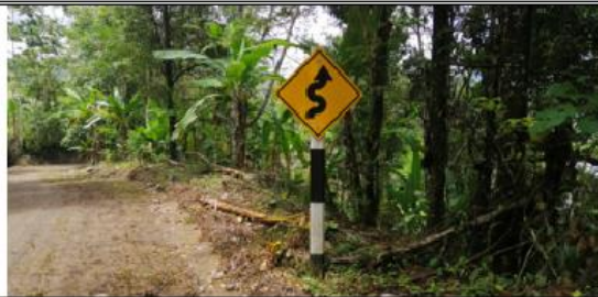
Fotografía 91: Prog. 04+210, señal preventiva en buen estado, ubicado en el lado izquierdo de la vía.
