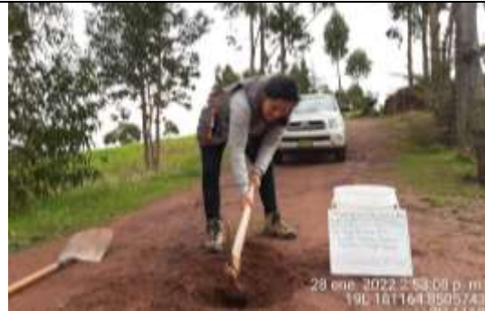
Fotografía 10. Apertura de la calicata 02.
