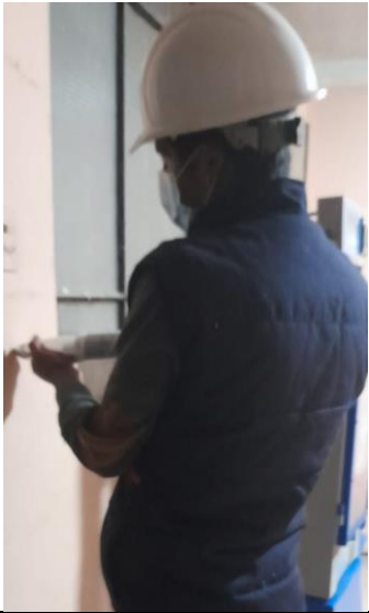
Ensayo de esclerómetro en columnas.
