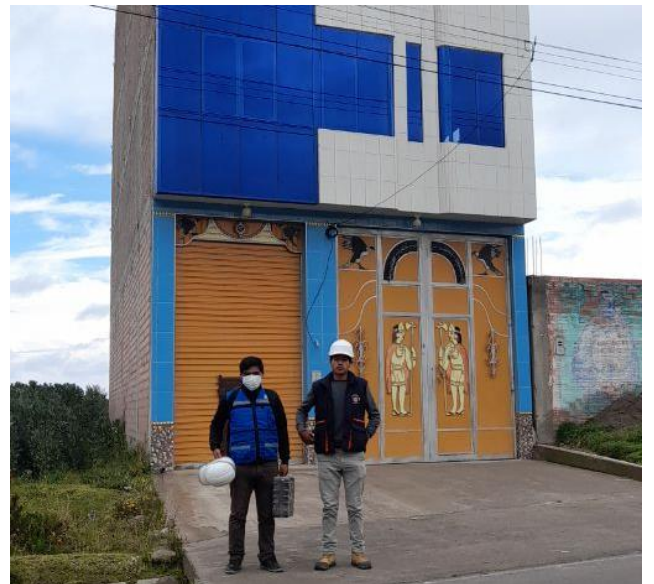
Vivienda 01, visita para el ensayo de esclerómetro.
