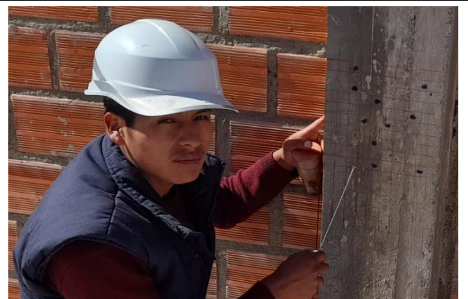
Delimitación del área y determinación de puntos para el ensayo de esclerómetro (columnas).
