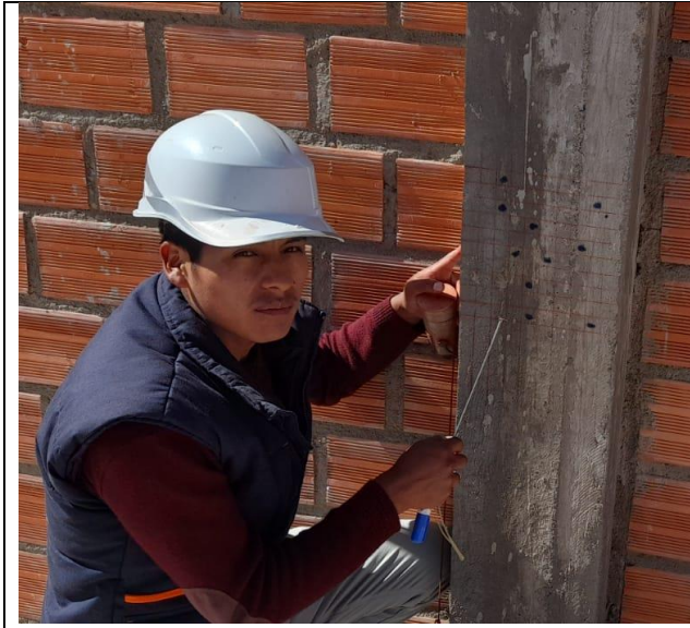
Figura 5. Ensayo de esclerómetro en columnas
