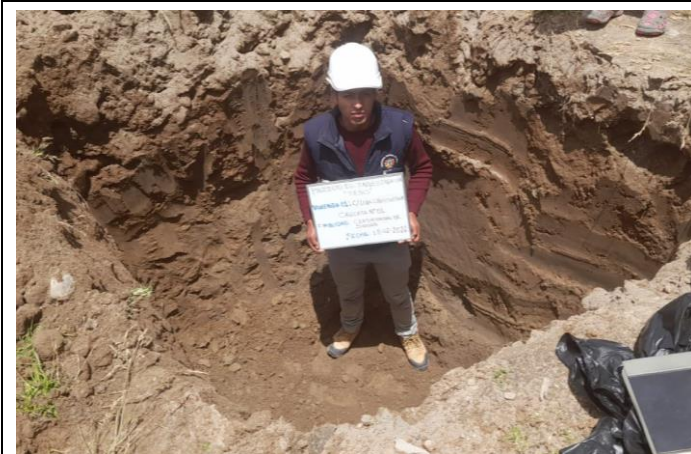
Calicata N° 01, vivienda 01 para el estudio de mecánica de suelos.
