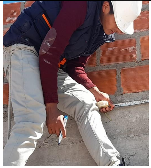
Figura 6. Ensayo de esclerómetro en vigas
