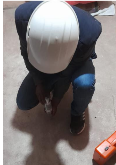
Ensayo de esclerómetro en losas.
