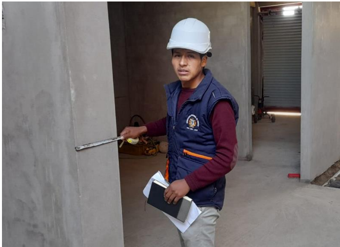
Recolección de datos de los elementos estructurales de la edificación. (columnas)
