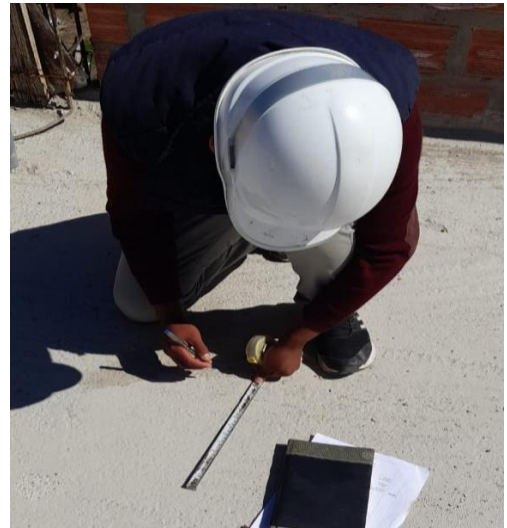
Delimitación del área y determinación de puntos para el ensayo de esclerómetro (losa).
