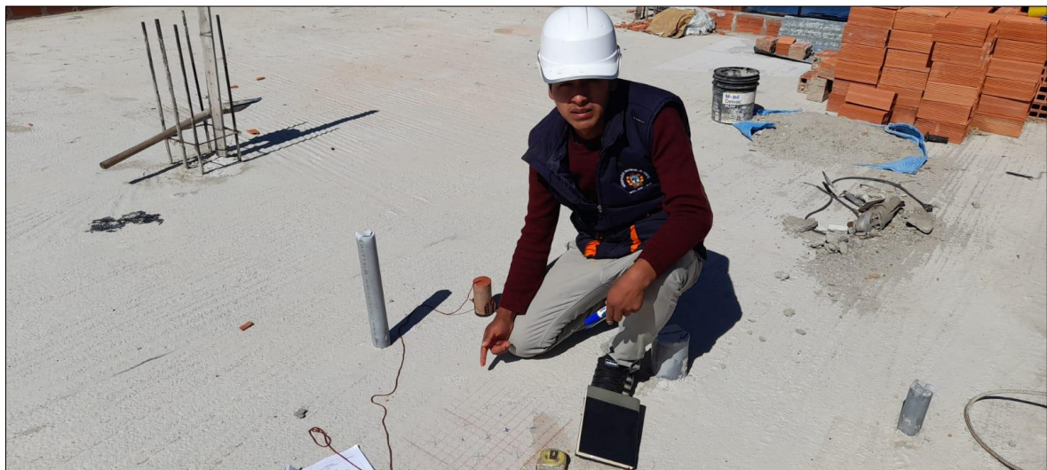
Figura 7. Ensayo de esclerómetro en losas
