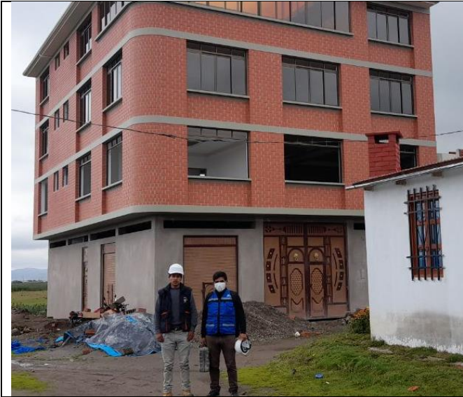
Vivienda 02, con losa de viguetas pretensadas y bovedillas de poliestireno.
