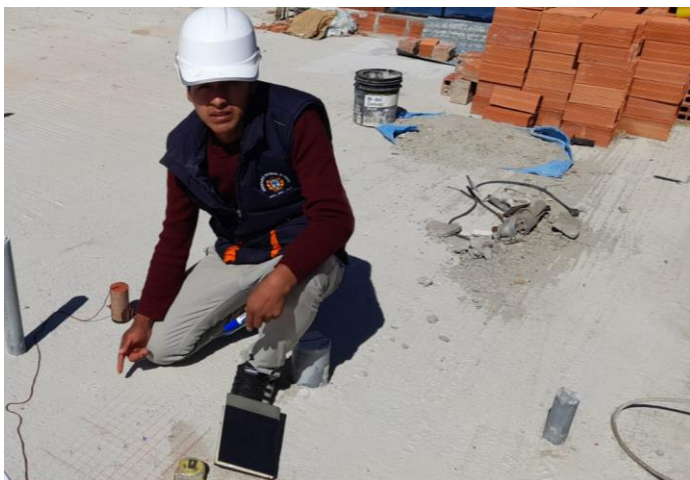
Determinación de puntos para el ensayo de esclerómetro (losa vivienda 02)
