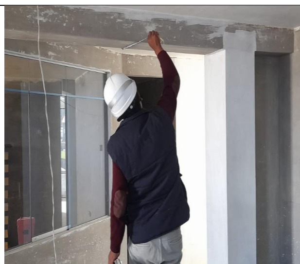
Figura 13. Vivienda 02, medición de elementos estructurales
