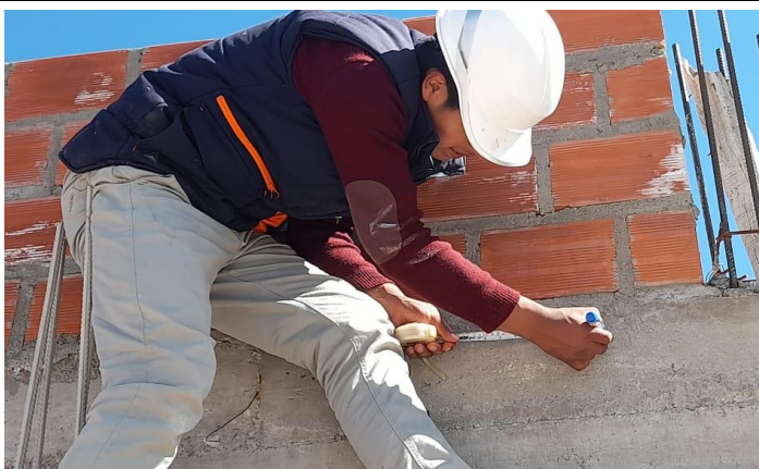
Recolección de datos de los elementos estructurales (losas).
