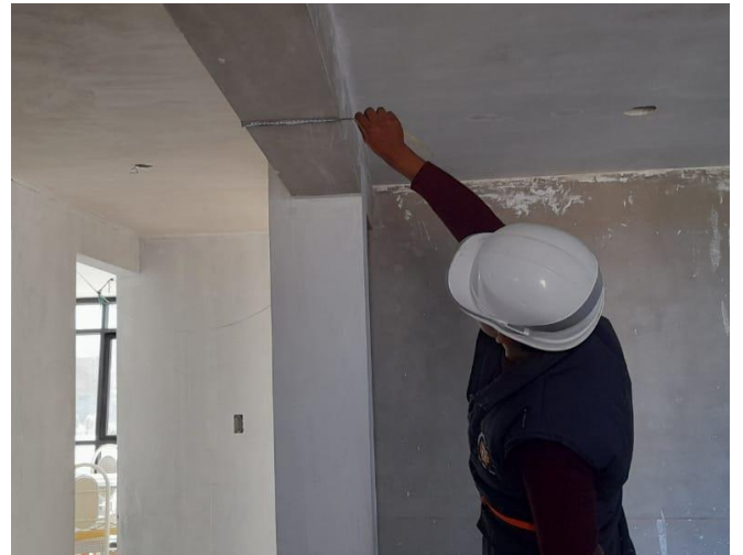
Recolección de datos de los elementos estructurales de la edificación. (vigas)
