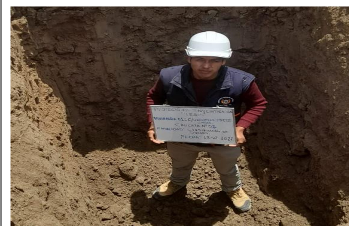
Calicata N° 02, Vivienda 02 para el estudio de mecánica de suelos
