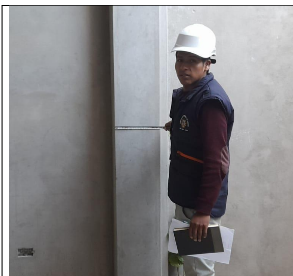
Figura 12. Vivienda 01, medición de elementos estructurales
