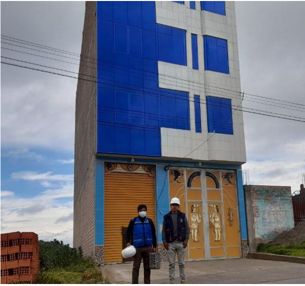
Vivienda 01, visita para el ensayo de esclerómetro.
