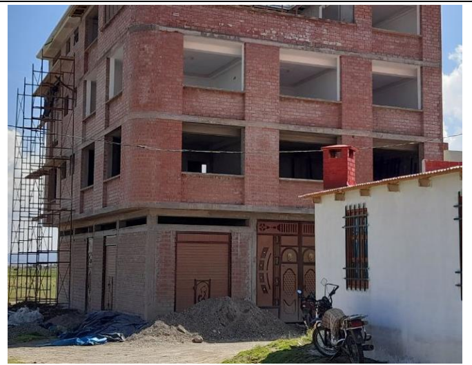
Vivienda 02, con losa de viguetas pretensadas y bovedillas de poliestireno.
