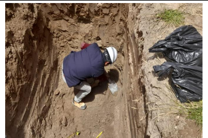
Recolección de datos de la calicata N° 01
