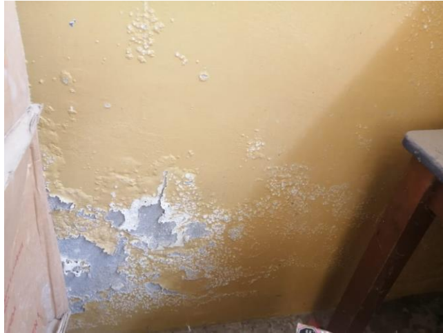
Figura 10.presencia de humedad.
