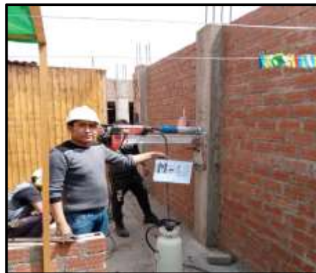
Extracción núcleo concreto Con Diamantina de la vivienda D-11.
