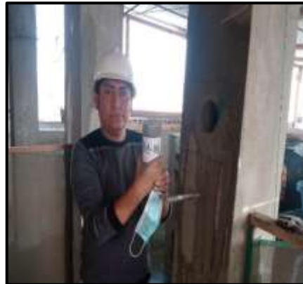
Extracción núcleo concreto Con Diamantina de la vivienda B-9.
