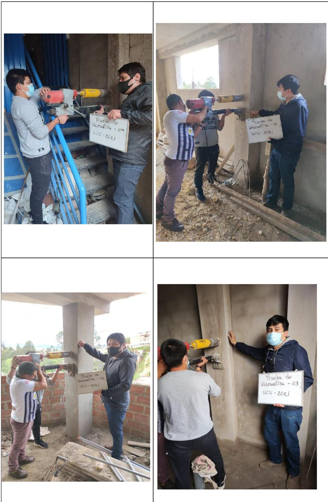
Figura 31: Extracción de núcleos de diamantina.
