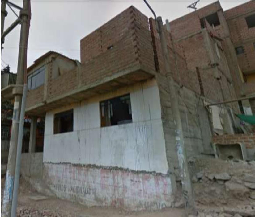
Figura 4: Vivienda de existente de estudio Fuente: Elaboración propia
