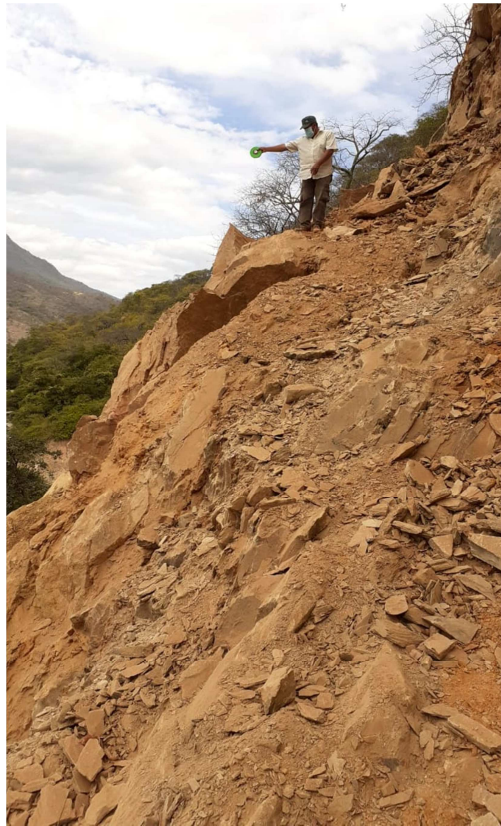
Corte de Roca con Explosivo
