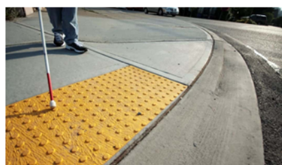
Figura: superficies podotáctiles en el diseño urbano aumenta y garantiza la accesibilidad universal. Inarquia.
