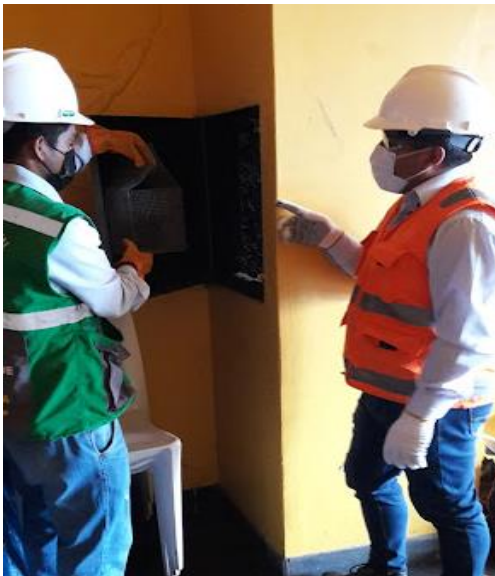
Figura 18: Traslado de filtro al local.
