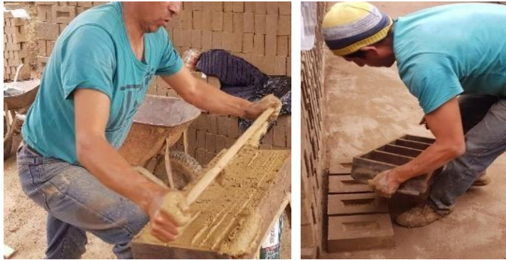
Figura 21: Moldeado de las unidades de albañilería
