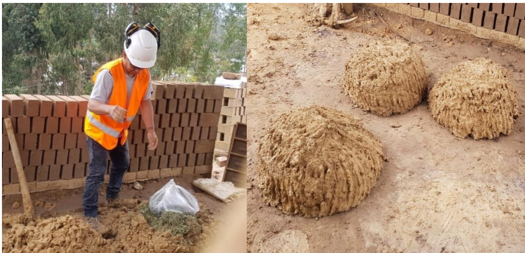
Figura 20: Mesclado de la arcilla con la fibra de retama
