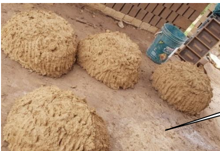
Incorporación de la fibra en la masa
