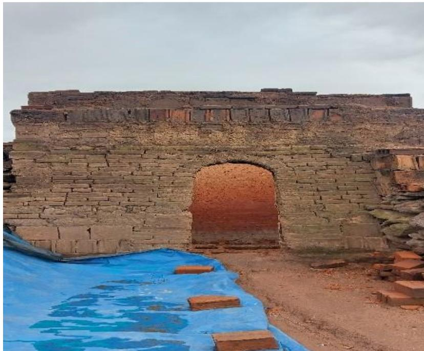
**Figura 17.** *Horno para coccion de ladrillos*
