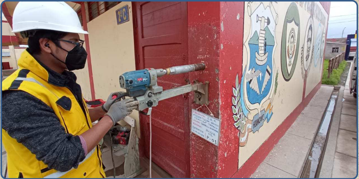
VISTA DE LA EXTRACCIÓN DE NUCLEOS MEDIANTE PERFORACIÓN DIAMANTINA P-01 REALIZADA EN LA COLUMNA
