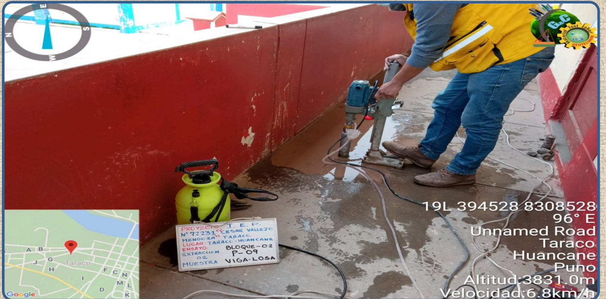
VISTA DE LA EXTRACCIÓN DE NUCLEOS MEDIANTE PERFORACIÓN DIAMANTINA P-09 REALIZADA EN LA VIGA-LOSA
