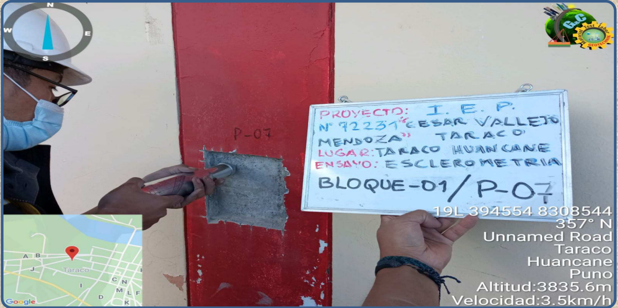
VISTA DE LA PRUEBA ESCLEROMETRICA P-07 REALIZADA EN LA COLUMNA
