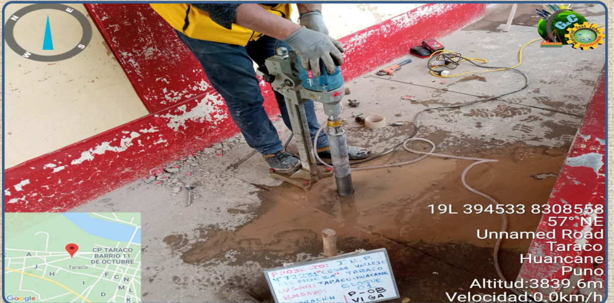
VISTA DE LA EXTRACCIÓN DE NUCLEOS MEDIANTE PERFORACIÓN DIAMANTINA P-08 REALIZADA EN LA VIGA-LOSA
