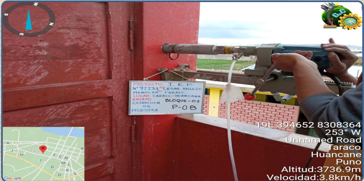
VISTA DE LA EXTRACCIÓN DE NUCLEOS MEDIANTE PERFORACIÓN DIAMANTINA P-08 REALIZADA EN LA COLUMNA
