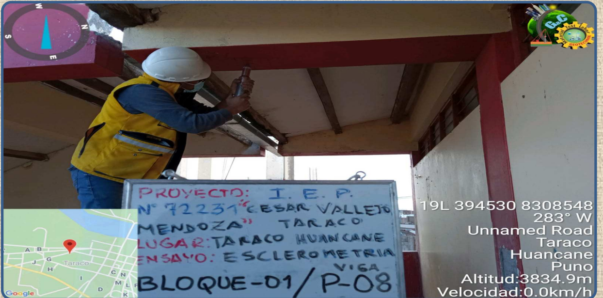
VISTA DE LA PRUEBA ESCLEROMETRICA P-08 REALIZADA EN LA VIGA
