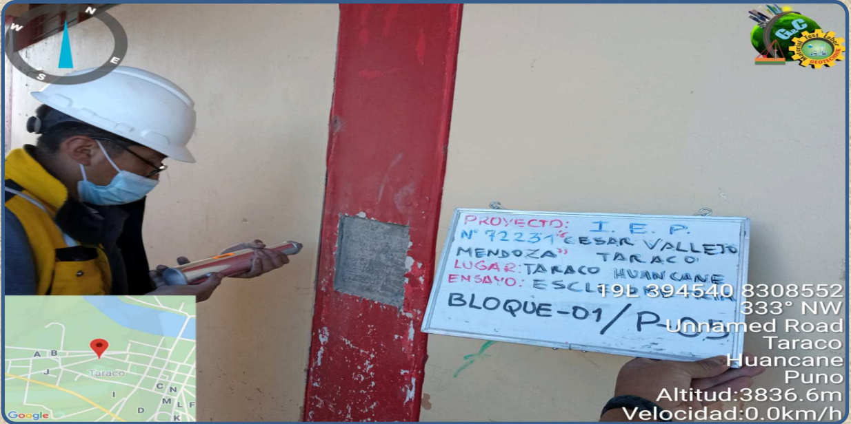
VISTA DE LA PRUEBA ESCLEROMETRICA P-05 REALIZADA EN LA COLUMNA
