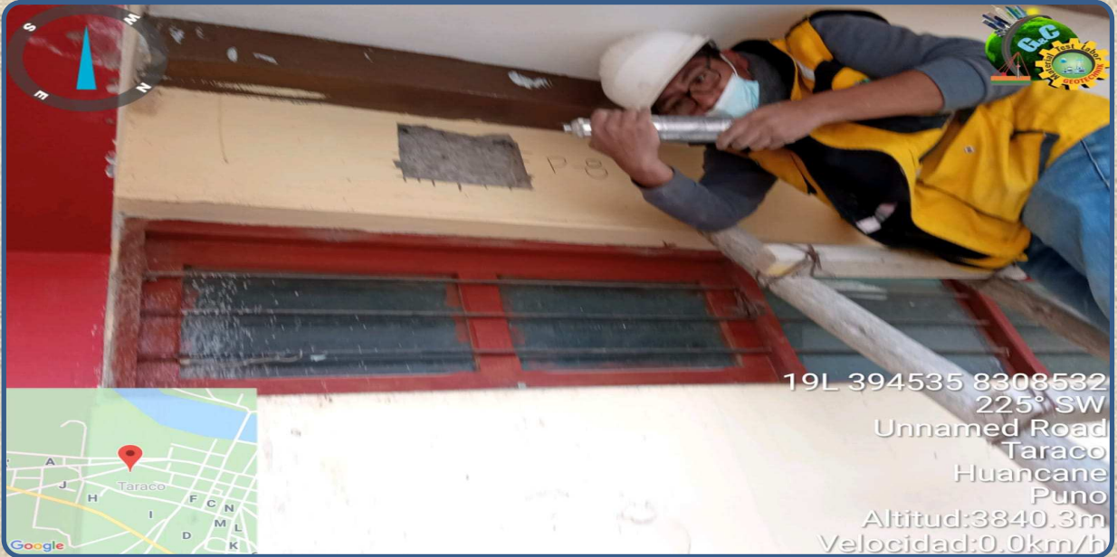
VISTA DE LA PRUEBA DE ESCLEROMETRIA P-08 REALIZADA EN LA VIGA
