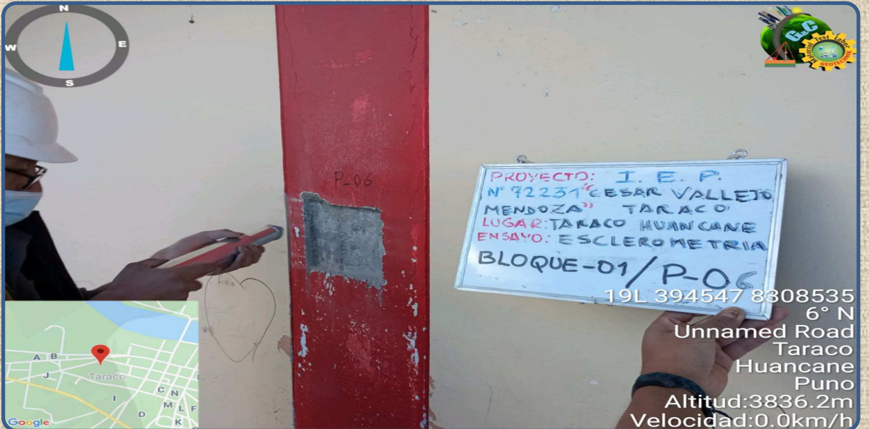
VISTA DE LA PRUEBA ESCLEROMETRICA P-06 REALIZADA EN LA COLUMNA
