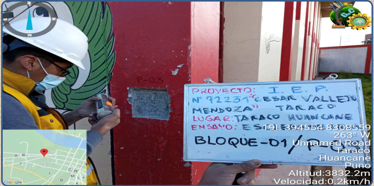
VISTA DE LA PRUEBA ESCLEROMETRICA P-03 REALIZADA EN LA COLUMNA
