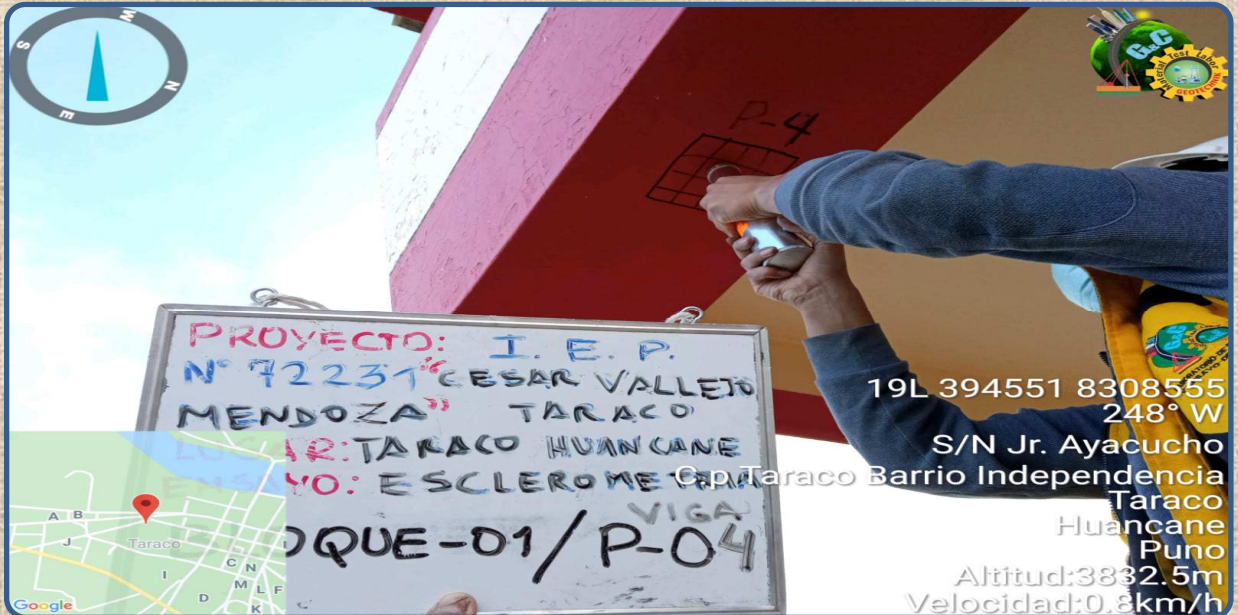
VISTA DE LA PRUEBA ESCLEROMETRICA P-04 REALIZADA EN LA COLUMNA
