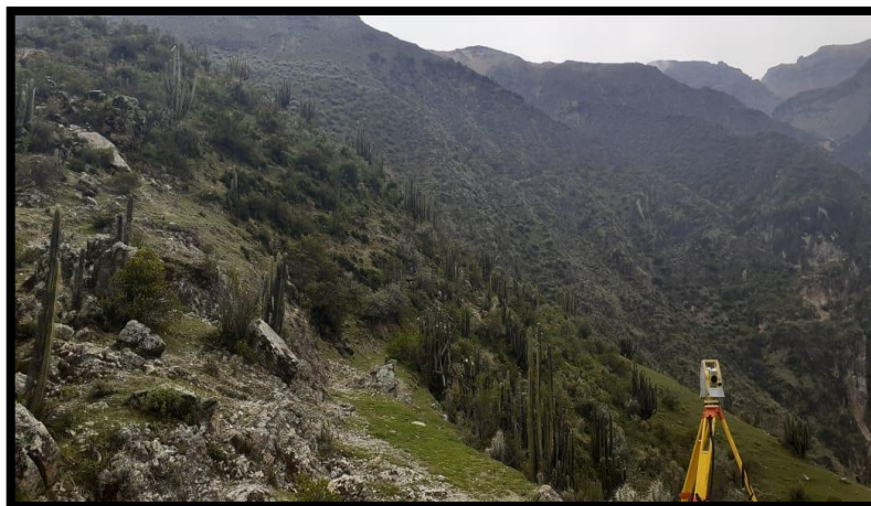
Figura 05: Realización del levantamiento topográfico con estación total
