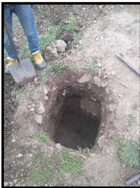
Figura 04: Realización de calicatas para estudio de estratos
