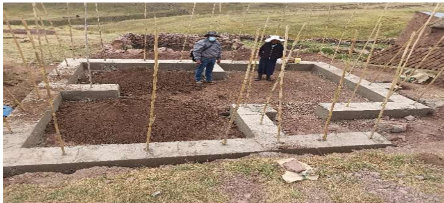
Figura 23. Muro con caña de carrizo
