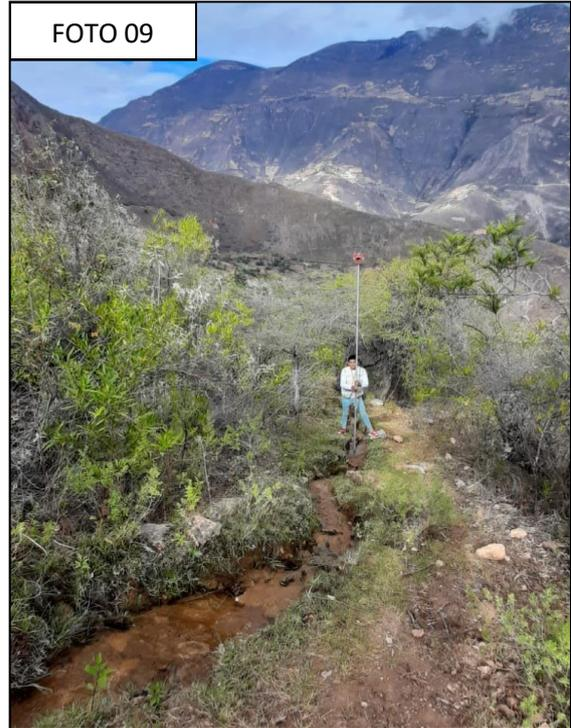
En la foto N° 08 y 09 se puede observar la lectura de puntos topográficos en campo tanto en el ramal N° 1 y en el ramal N° 2 que se presenta en nuestra línea de conducción
