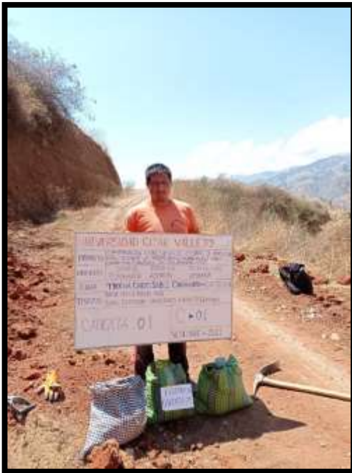
Figura 01. Excavacion de la calicata 01
