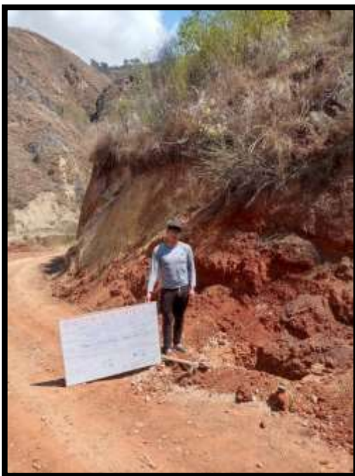
Figura 03. Excavacion de la calicata 01
