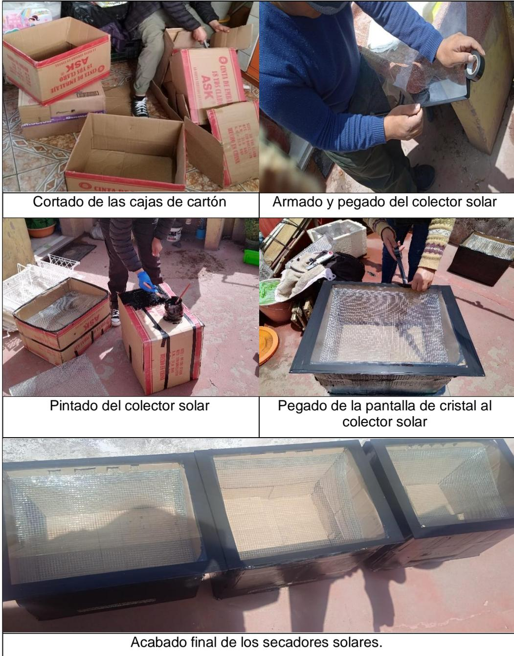
Figura 9: Armado, ensamblado y acabado del equipo solar (secador solar).
