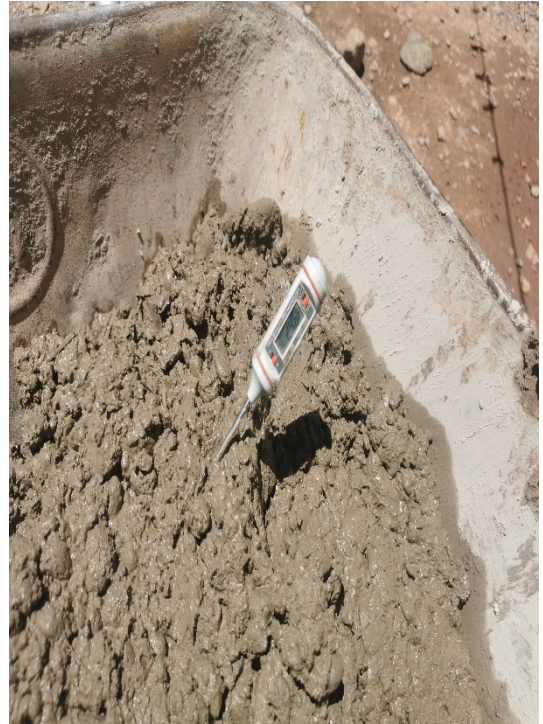
Fotografía N° 7: Temperatura del concreto. Fuente: Elaboración propia.
