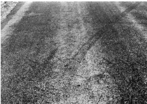
Figura 9. Falla Exudación
