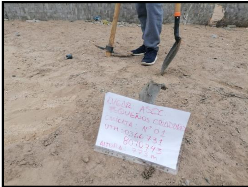
UBICACIÓN DE CALICATA 01
