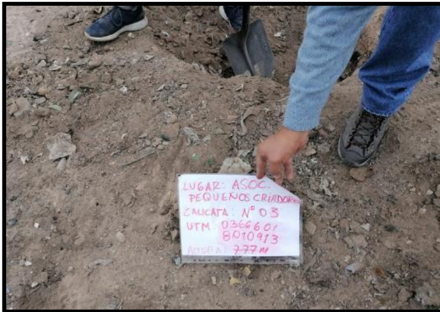
UBICACIÓN DE CALICATA 03
