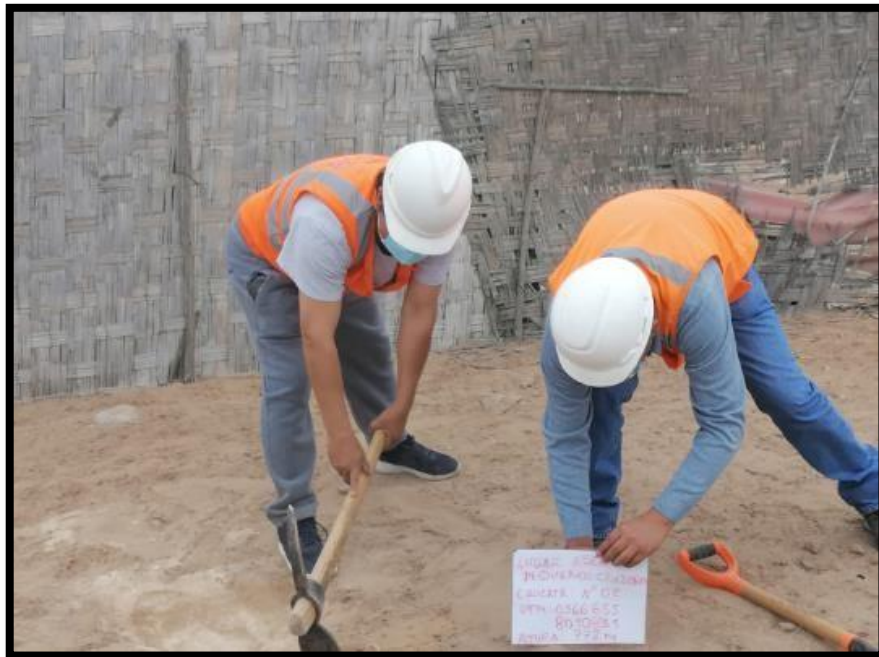
UBICACIÓN DE CALICATA 02
