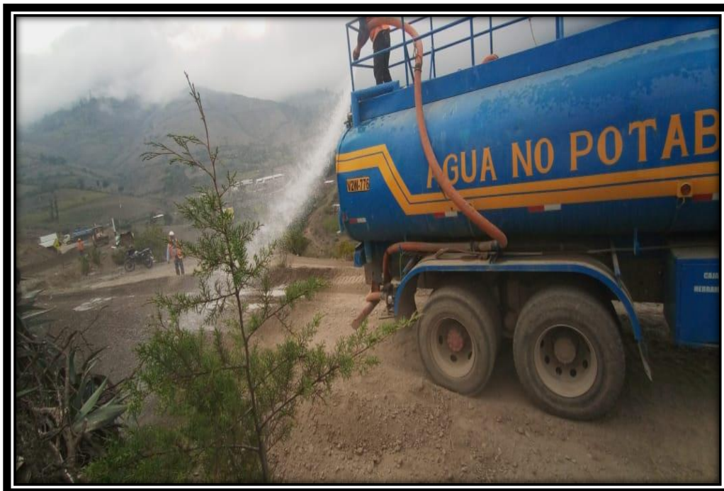
Fotografía n° 08: Aplicación de Agua con Aditivo Conaid.
