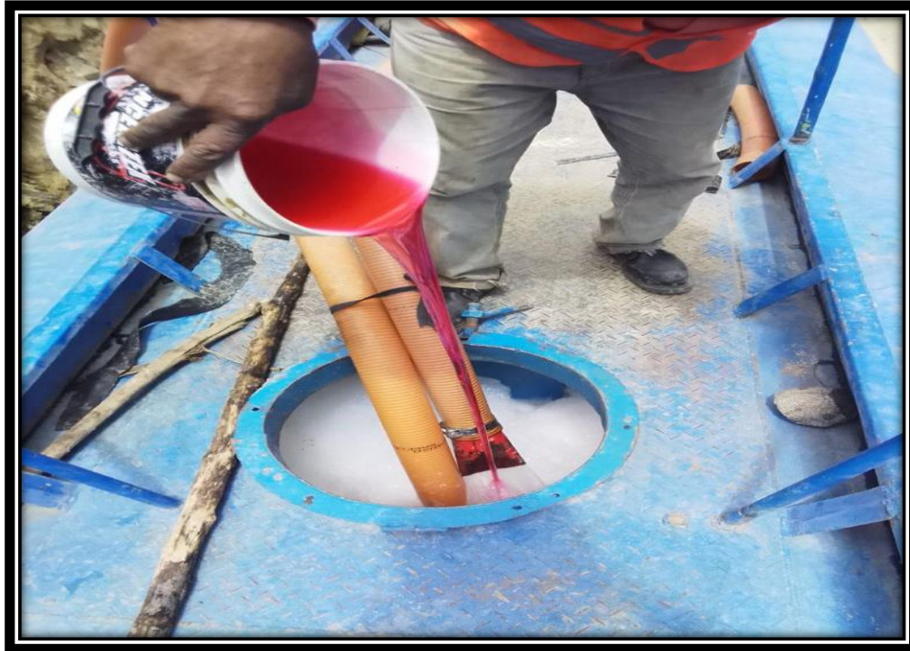
Fotografía n° 07: Aplicación de Aditivo Conaid.
