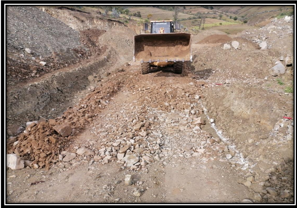
Fotografía n° 04: Mejoramiento con Over.
