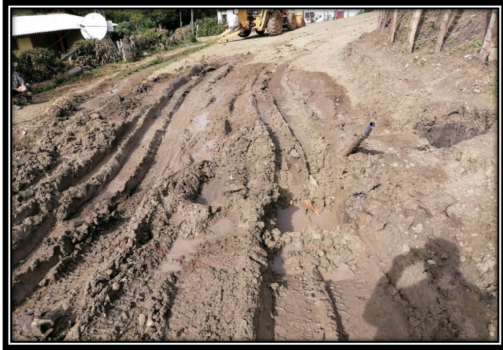
Fotografía n° 01: Estado inicial de la Vía.
