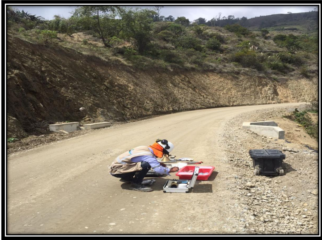
Fotografía n° 09: Realización del Estudio de Mecánica de Suelos.
