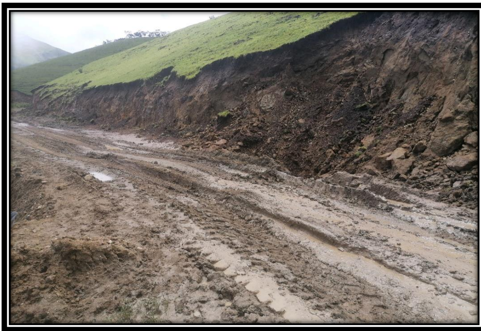
Fotografía n° 02: Estado inicial de la Vía.
