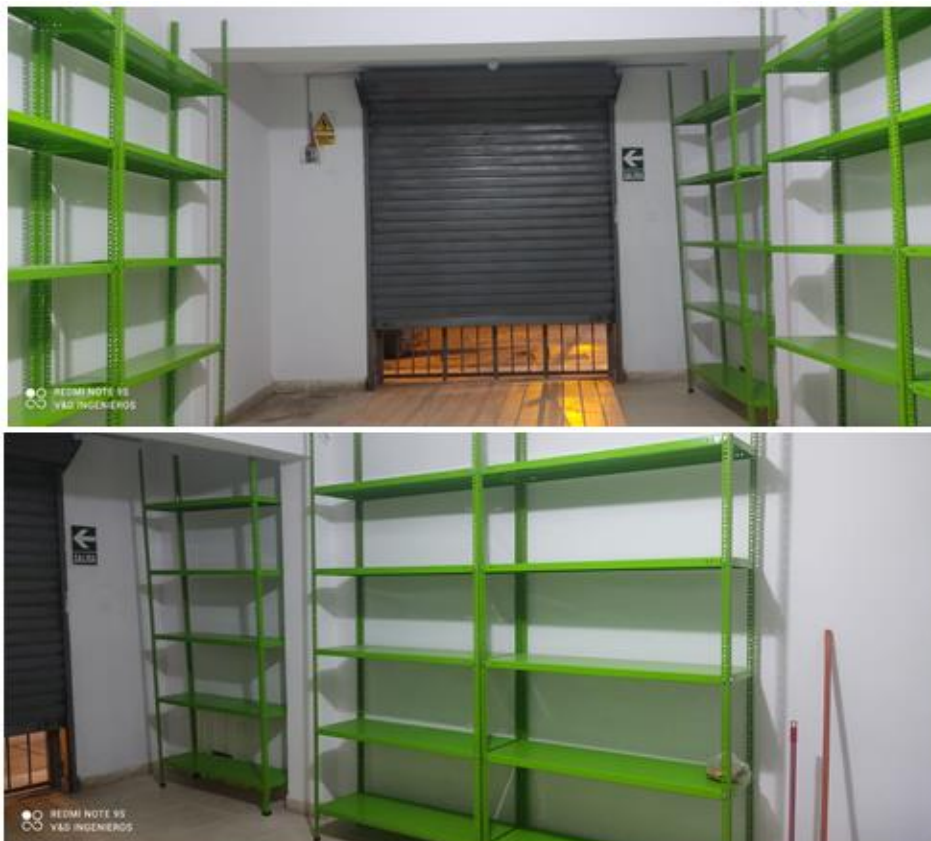
Figura 47: Instalación de anaqueles en el área de almacén
