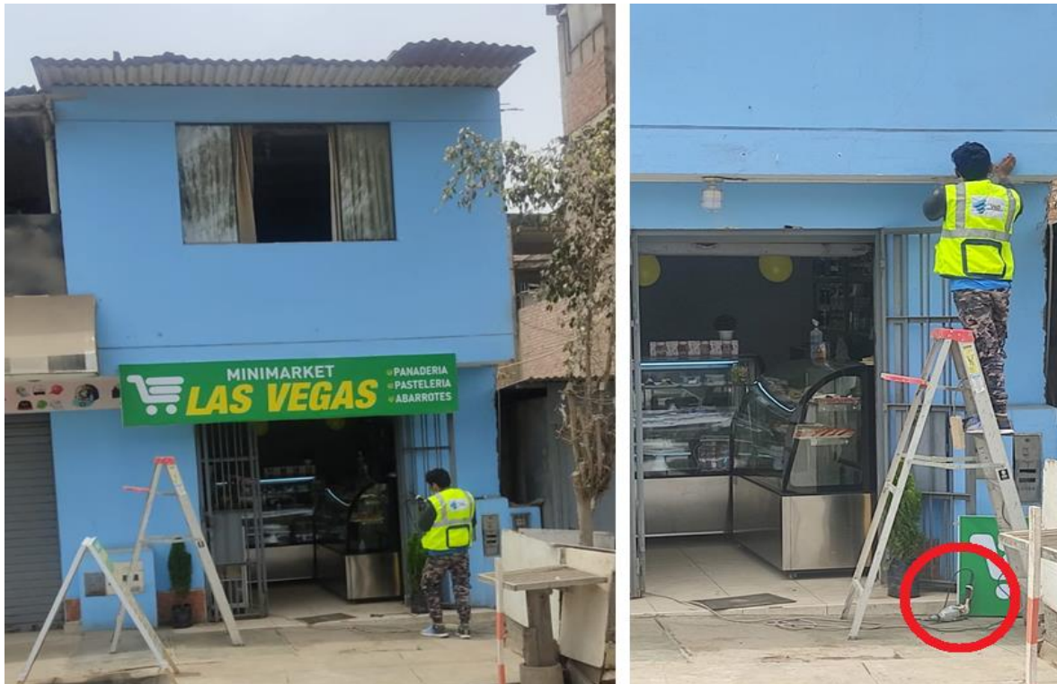
Figura 22: Trabajos en pintura e instalación de banners.
