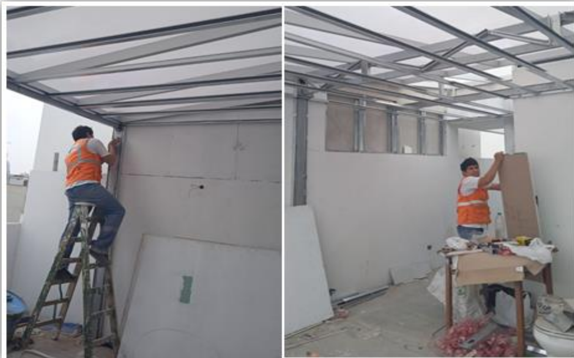
Figura 21: Trabajos de implementación de drywall.
