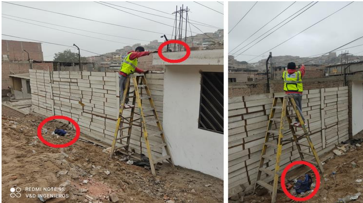
Figura 19: Trabajos de corrección eléctrica.
