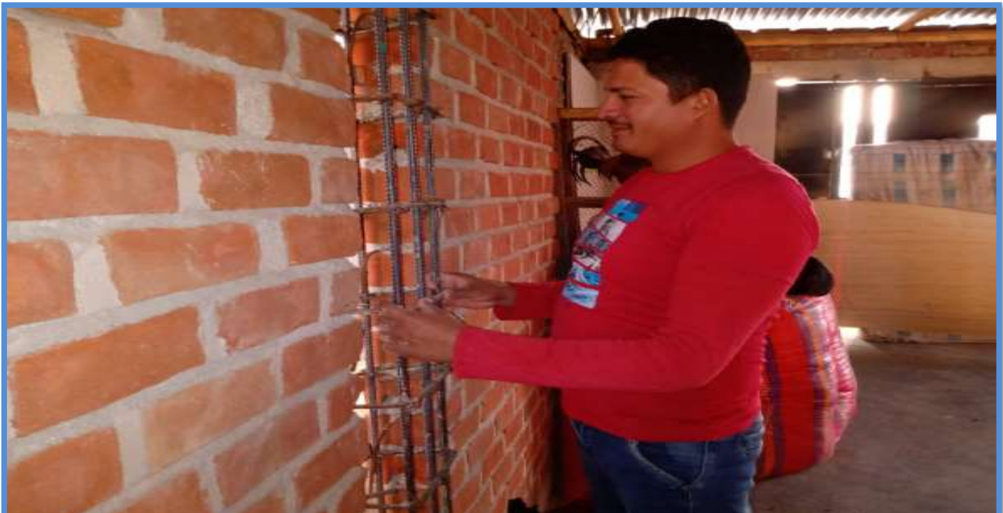
Observacion de procedimiento constructivo
