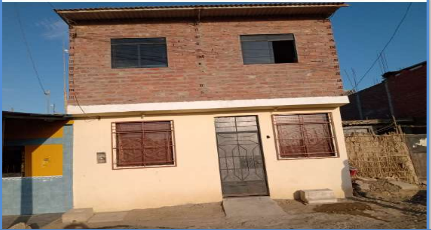
Utilizacion de Ladrillo Pandereta en Construcción
