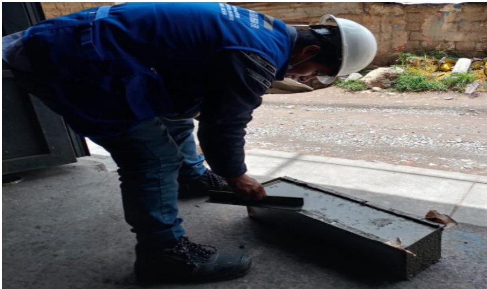
Fabricación de vigas
