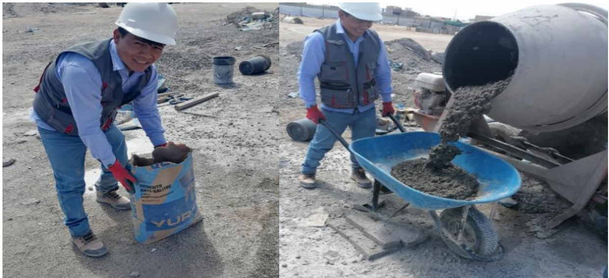
Preparando mezcla para fabricación de briquetas con ayuda de batidor de concreto
