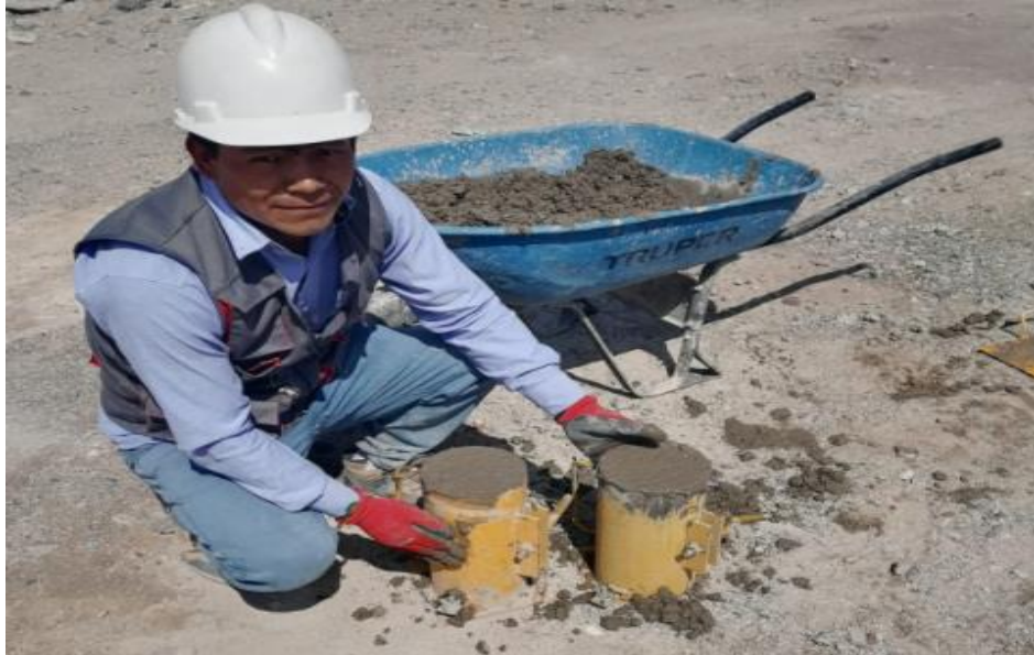
Fabricación de briquetas cilíndricas de concreto
