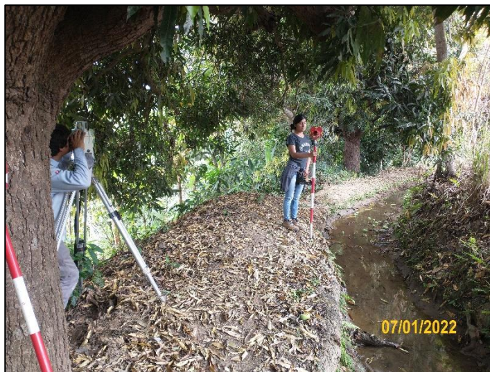
Fotografía N°04: Levantamiento de sección de canal
