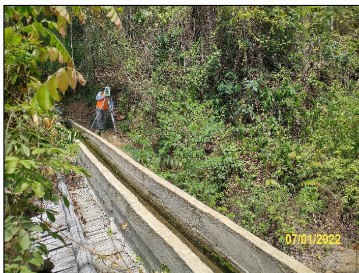
Fotografía N°03: Levantamiento de Acueducto sobre Quebrada.
