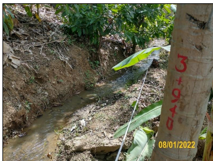
Fotografía N°05: Pintado de progresivas
