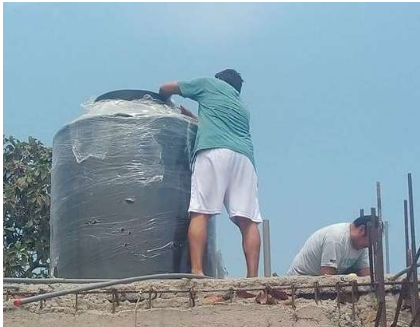
Instalación del tanque de almacenamiento (1100L).
