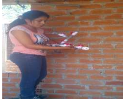
Pre-instalación de accesorios
