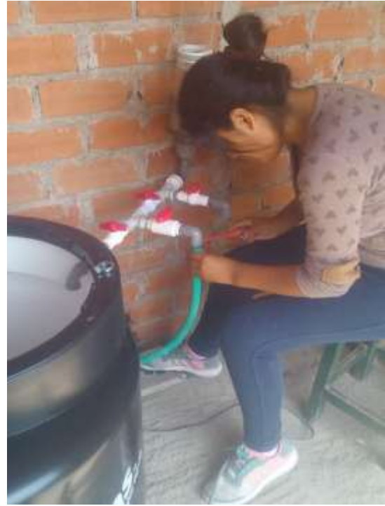
Instalación de manguera
