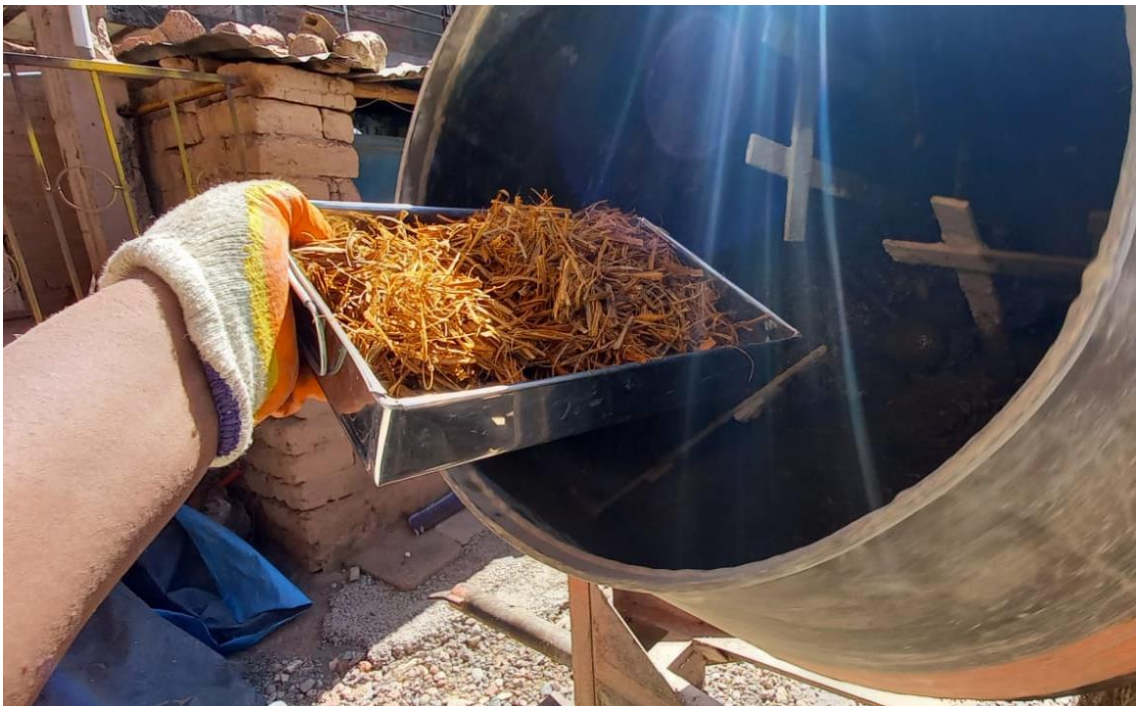
Fotografía 10: mezcla del concreto
