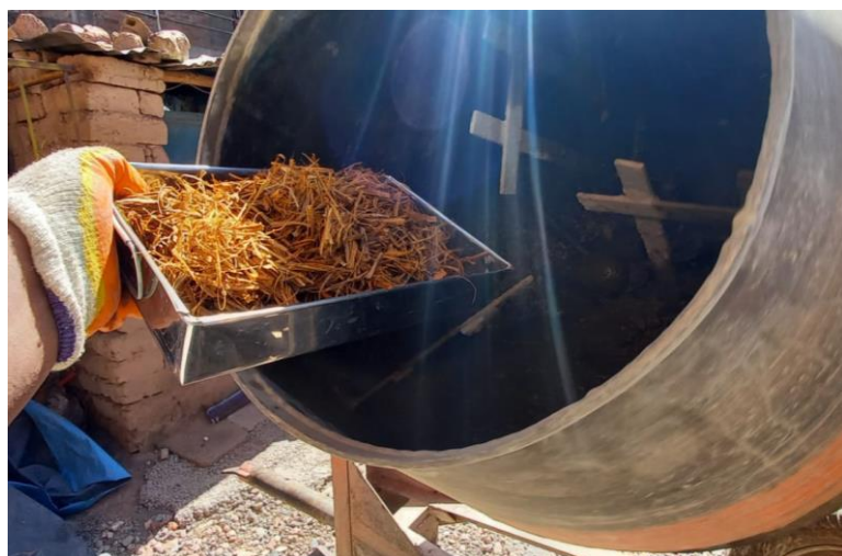
Figura 26: Mezcla de concreto con fibra de corteza de linaza
