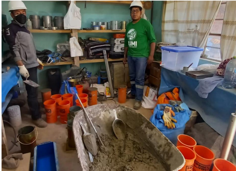
Figura 25: Mezclado de agregados, cemento y agua, para concreto convencional
