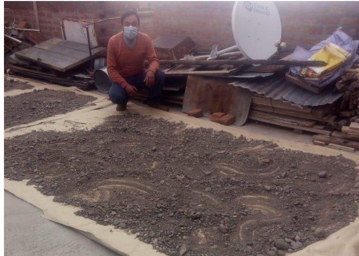
Figura 14: Secado de los agregados extraídos de la cantera
