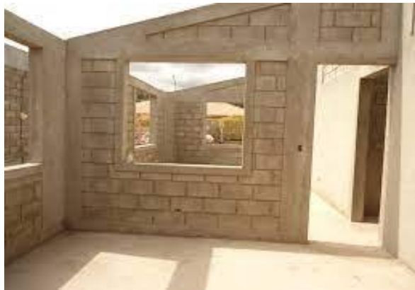
Figura 1.1 Muros de albañilería con ladrillos artesanales
