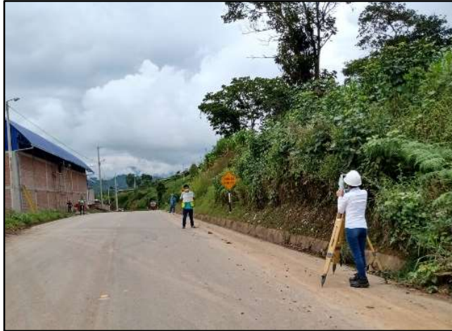
Figura 13. Progresiva: Km. 0+000.00 al Km. 1+000.00
