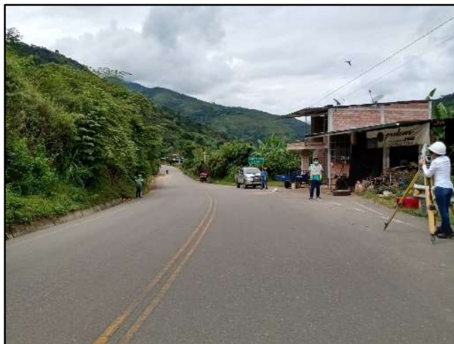
Figura 15. Progresiva: Km. 2+000.00 al Km. 3+000.00
