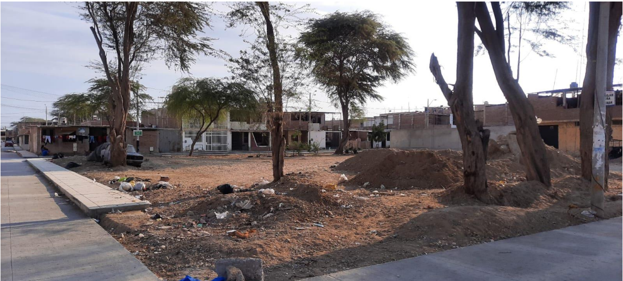
Espacios públicos del conjunto habitacional Micaela Bastida de la III etapa, en estado abandono, contaminación ambiental e invasión de desechos de materiales de construcción. Fuente: Elaboración propia
