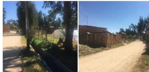
Fig. 2. Vías y construcciones al entorno del terreno.
