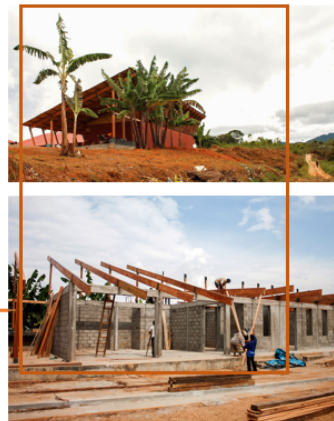
Fig. 2. Vistas fotográficas del proceso constructivo. Fuente: https://habitar-arq.blogspot.com/2014/06/escuela-en-chuquibambilla.html
