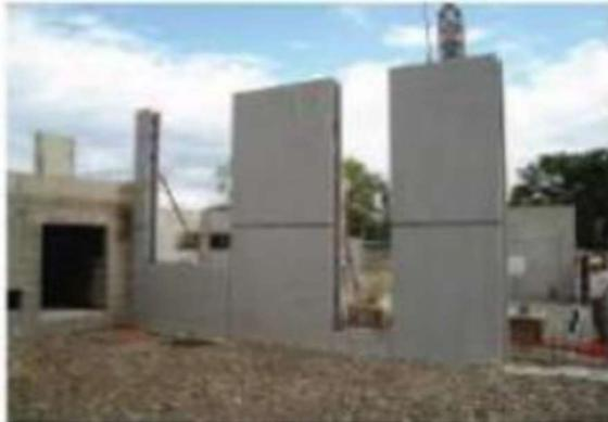
Se han diseñado muros perimetrales estructurales y columnas a base de prefabricados de hormigón como estructura trampolín que se puede construir sobre ella con cualquier material disponible.
