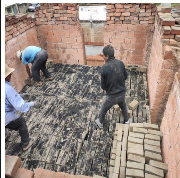
**Fotografía 19:** Colocación de ladrillo en el hornillo artesanal
