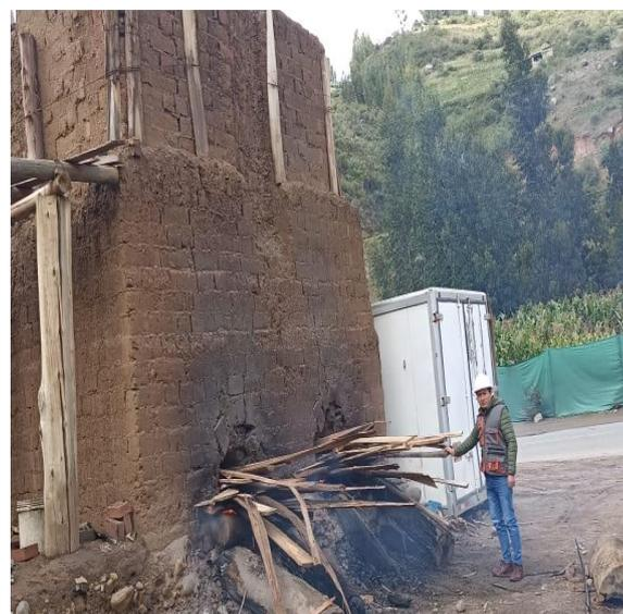
**Fotografía 22:** Proceso de quemado de ladrillo en el hornillo artesanal
