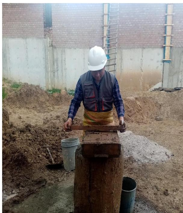
**Fotografía 13:** Nivelación con madera el moldeado del ladrillo
