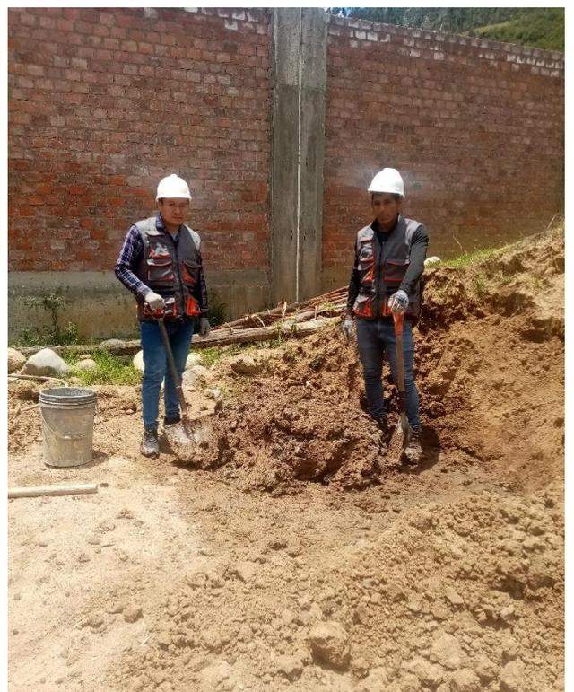
**Fotografía 04:** Preparación de la Mezcla con Arcilla
