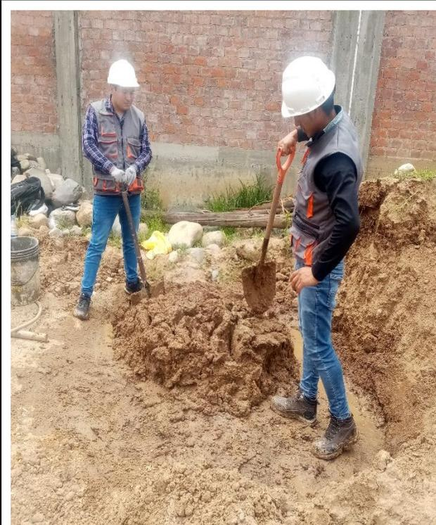
**Fotografía 09:** Preparación de la mezcla con arcilla
