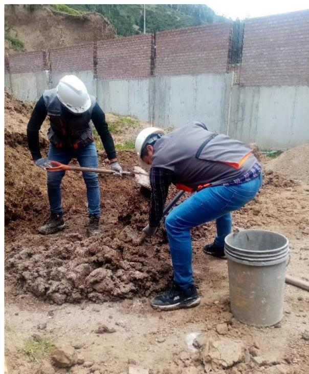
**Fotografía 08:** Preparación de la Mezcla con Arcilla con adición de paja de ichu y ceniza paja de cebada
