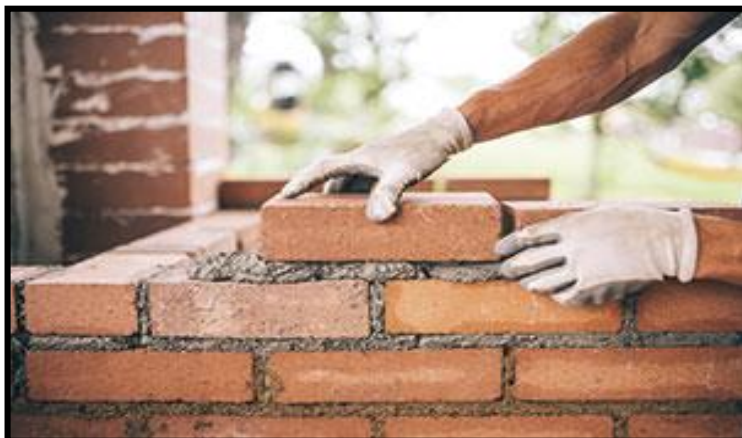
Figura 5. Mortero usado en asentamiento de ladrillos
