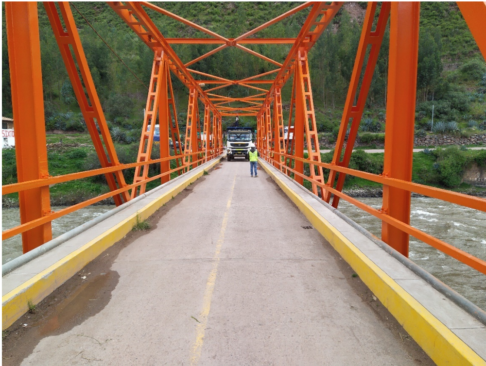
Proceso de carga de la superestructura con del camión de prueba
