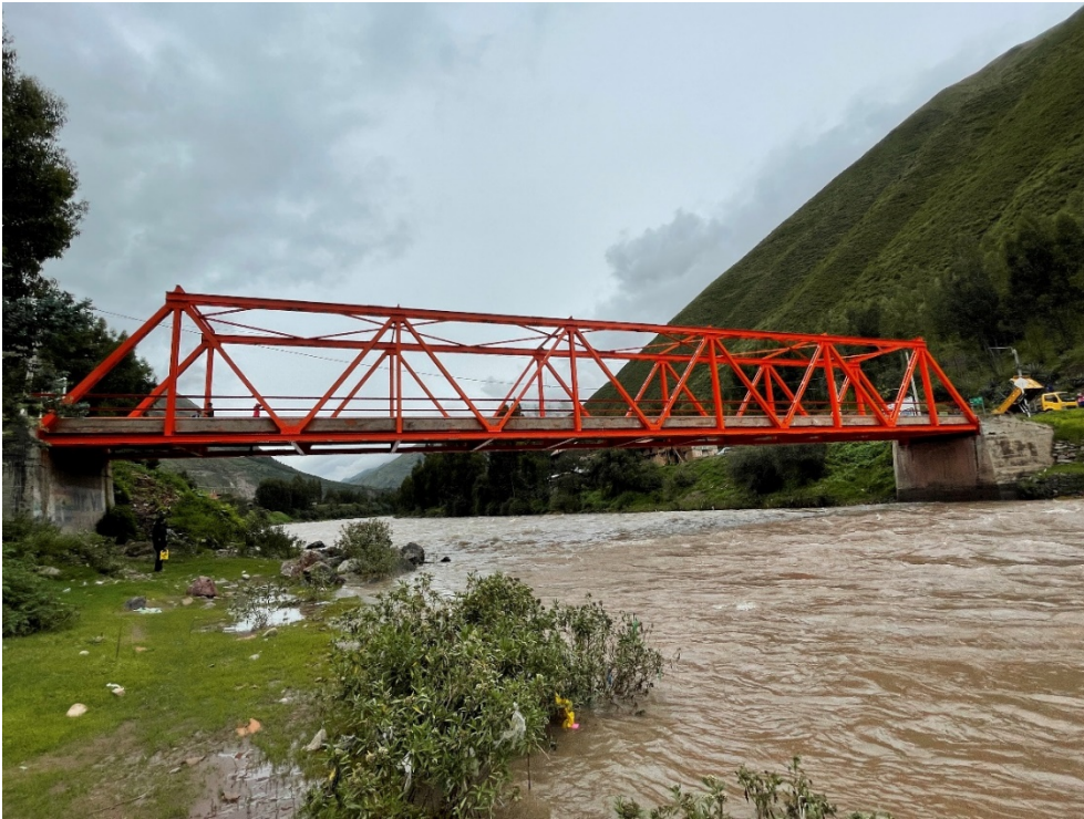
Vista desde aguas debajo de la estructura de puente Quiquijana
