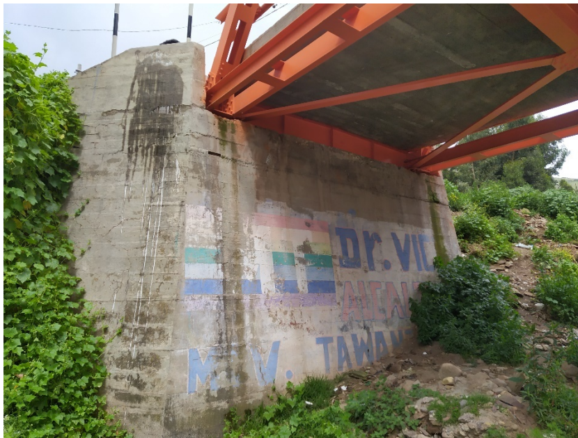
Figura 9: Vista de estribo derecho.
