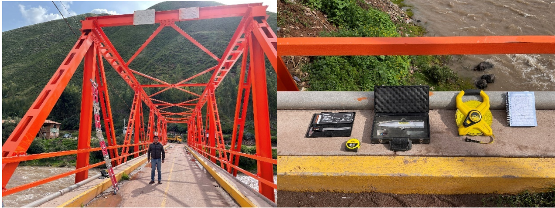
Figura 10: Vista de vigas transversales de tablero.
