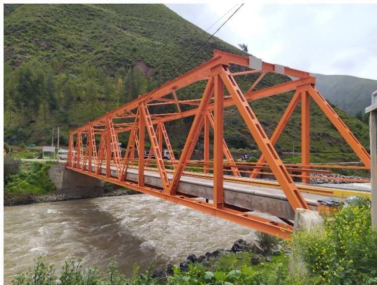
Figura 7: Vista de la superestructura.
