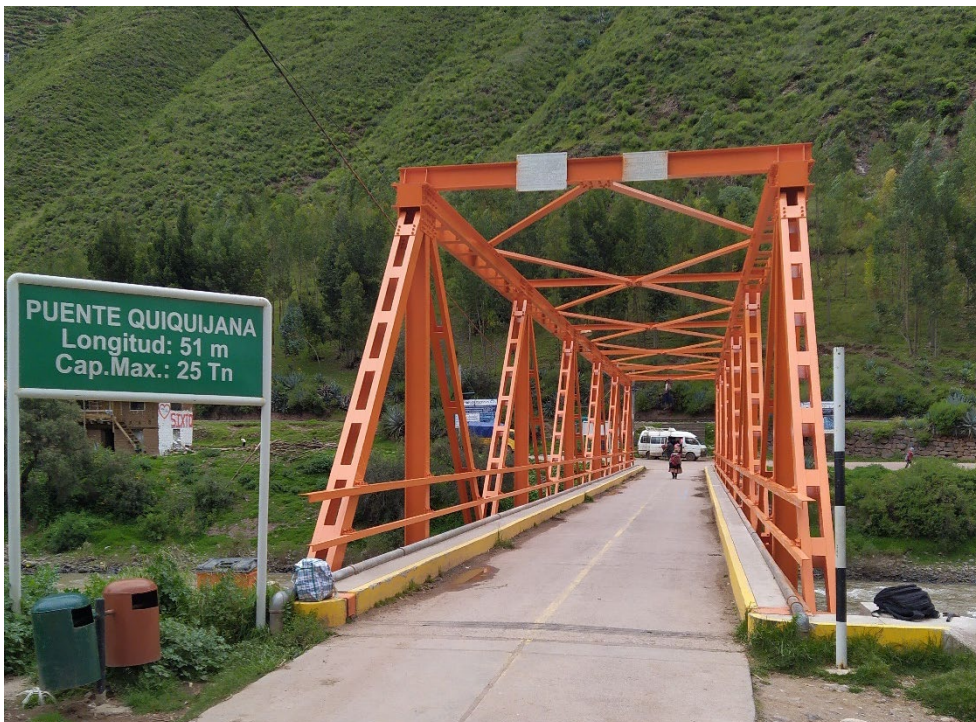
Vista frontal del puente Quiquijana
