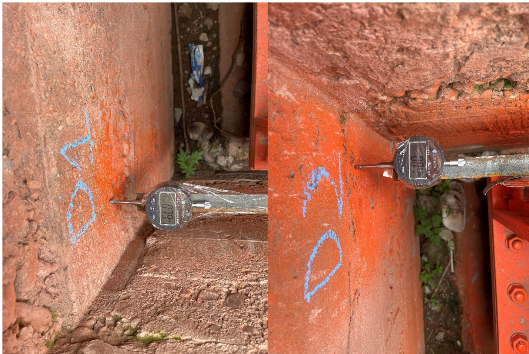
Ubicación y lectura de deformímetros para medir los desplazamientos horizontales.
