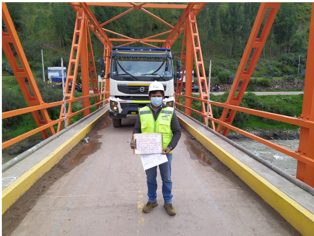
Ubicación del camión de carga en el centro de luz del puente
