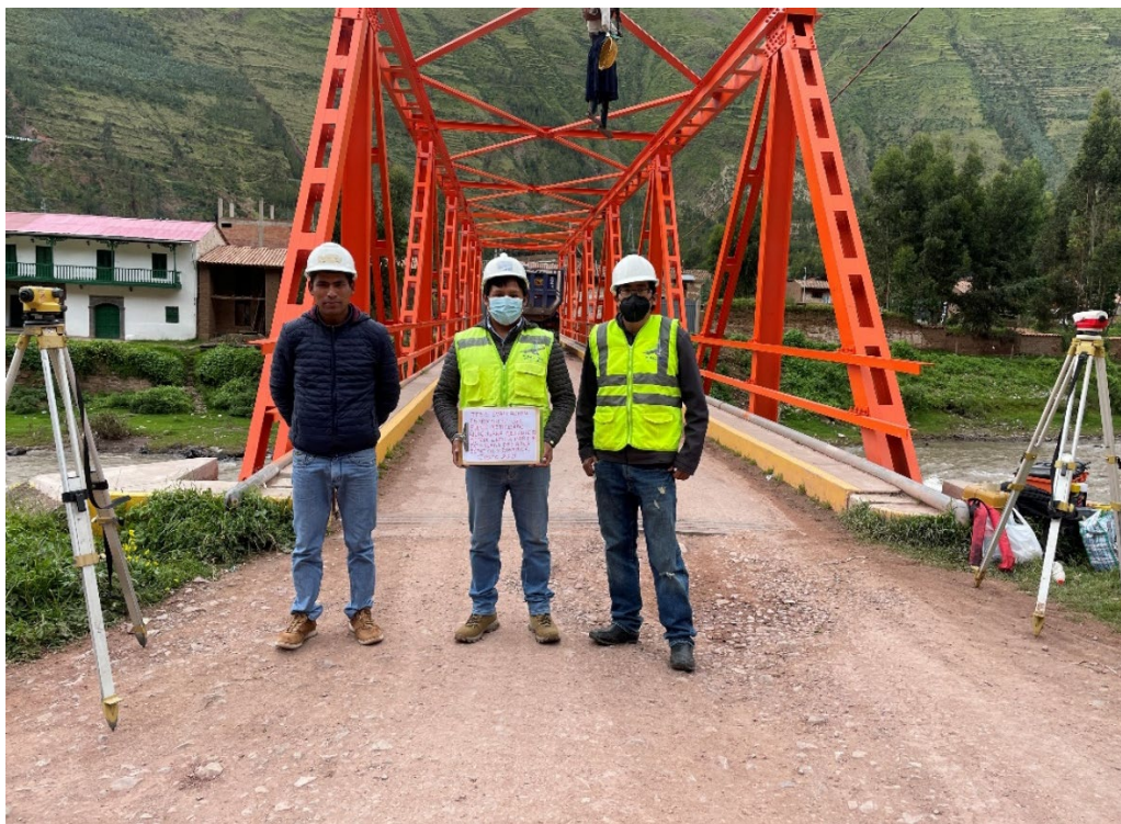
Personal técnico de la prueba de carga de la superestructura del puente Quiquijana
