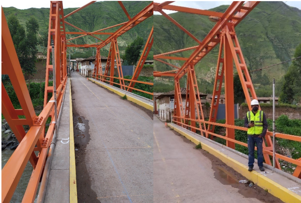
Ubicación de miras en centro de luz del puente para toma de lecturas y medición de las deformaciones verticales
