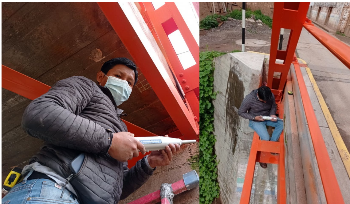
Ensayos de esclerometría para diagnosticar la capacidad de resistencia del estribo y tablero.
