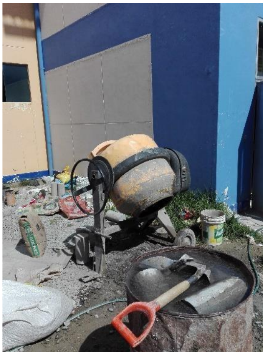
Figura 36. Preparación de la mezcla
