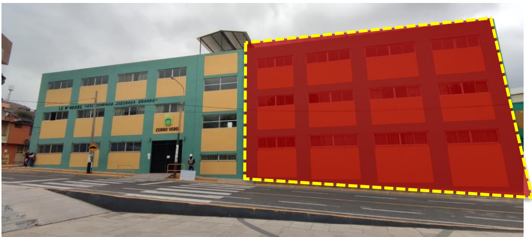
Figura 9 Vista fachada Pabellón A - I.E. N°40092 Fuente Propia
