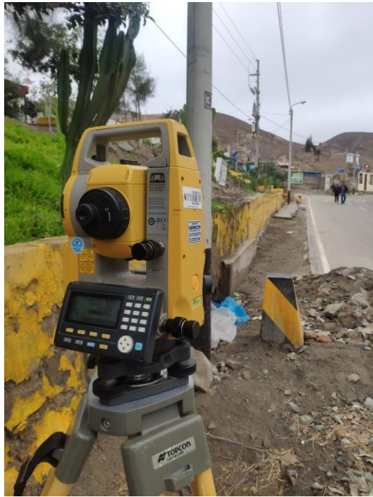
Calibración del equipo (Estación Total)
