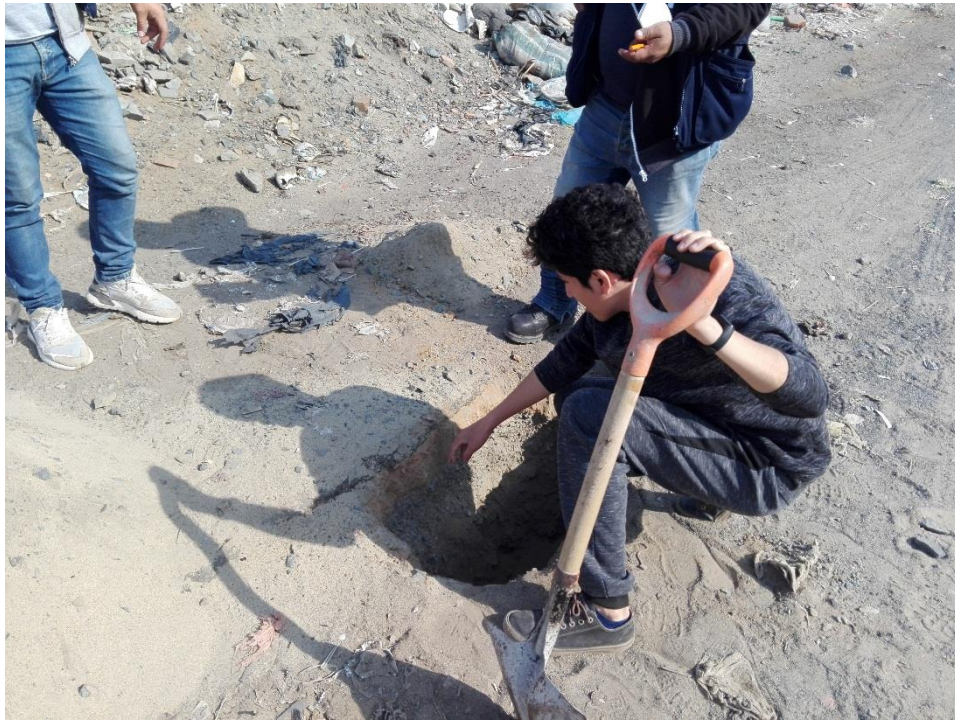
Realización de la Calicata 1.00x1.00m.
