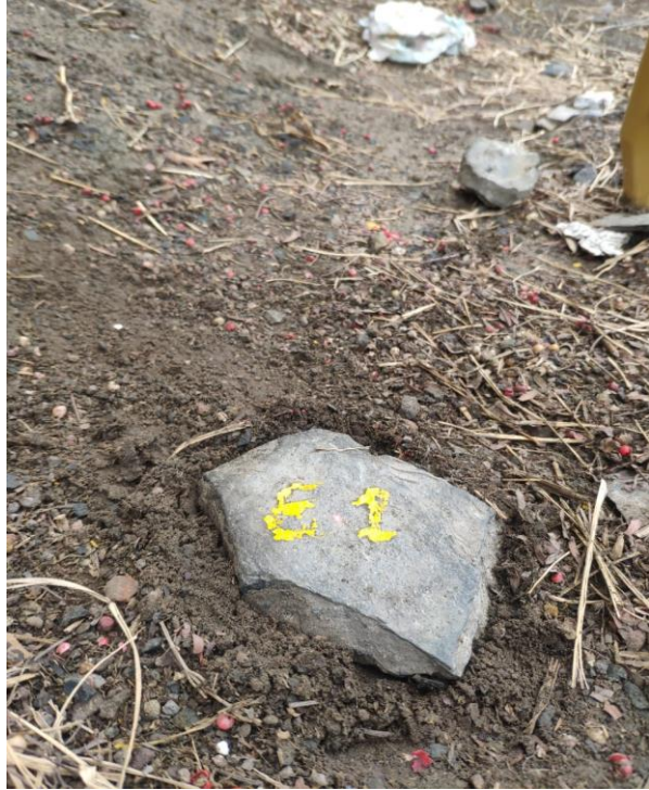
Colocación de puntos de las estaciones
