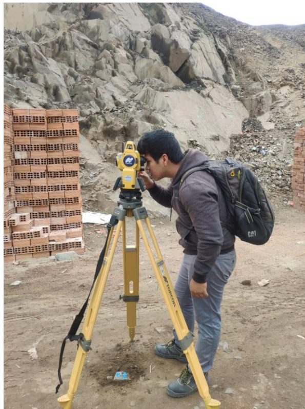
Levantamiento topográfico con Estación Total
