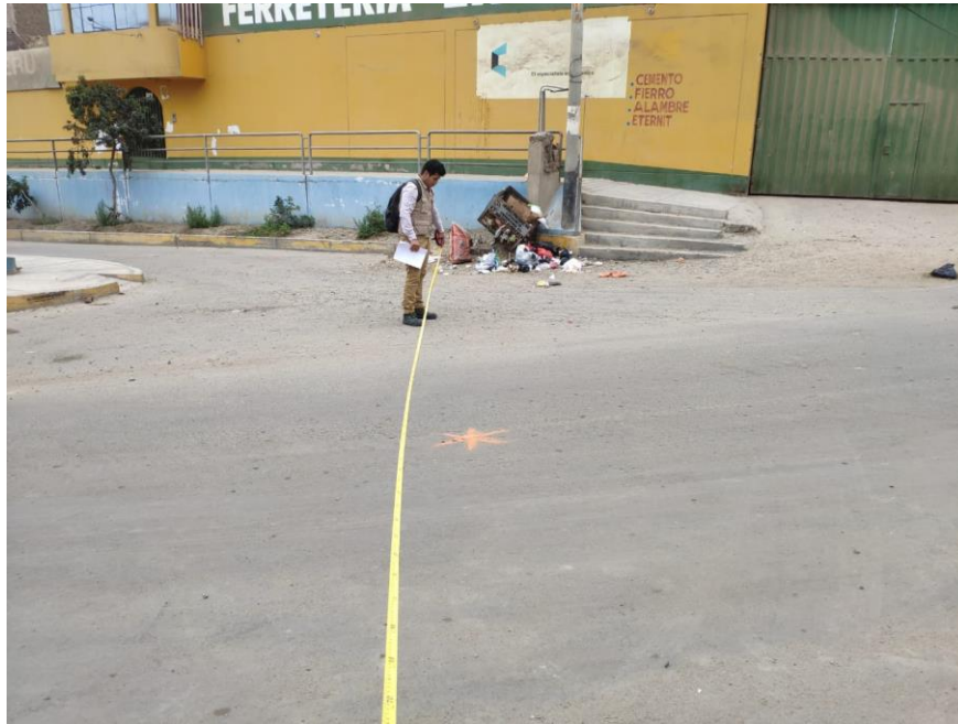
Progresiva 0+000, inicio a evaluar las fallas superficiales (Patologías)
