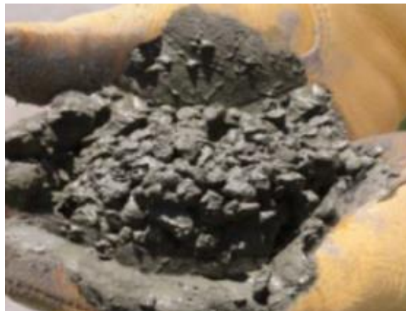
Figura 9. Concreto poroso con demasiada cantidad de agua.
